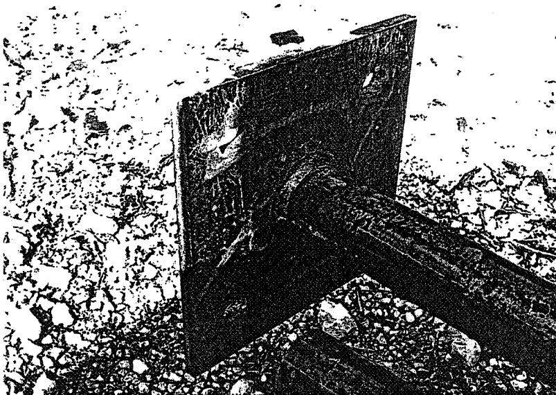
Abbildung 37: Massive Schweissnaht. Pfosten - Fussplatte.
