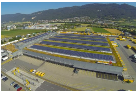
Quelle Foto: www.post.ch
