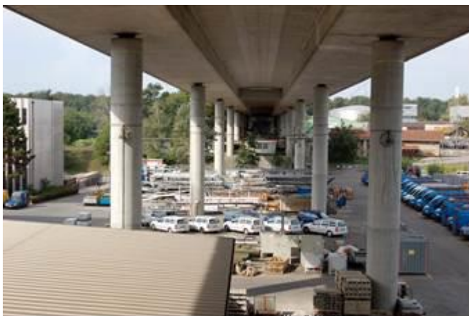
Abb. I-10 Untersicht des Weyermannshaus Viadukts mit Lage der Strassenbahnlinie zwischen den Stützen, Joch N in Mitte, Joch O im Hintergrund.
