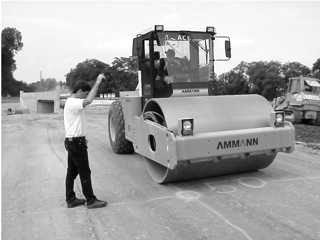
Abbildung 5-2: Messung der FDVK-Werte mit einem Walzenzug.
