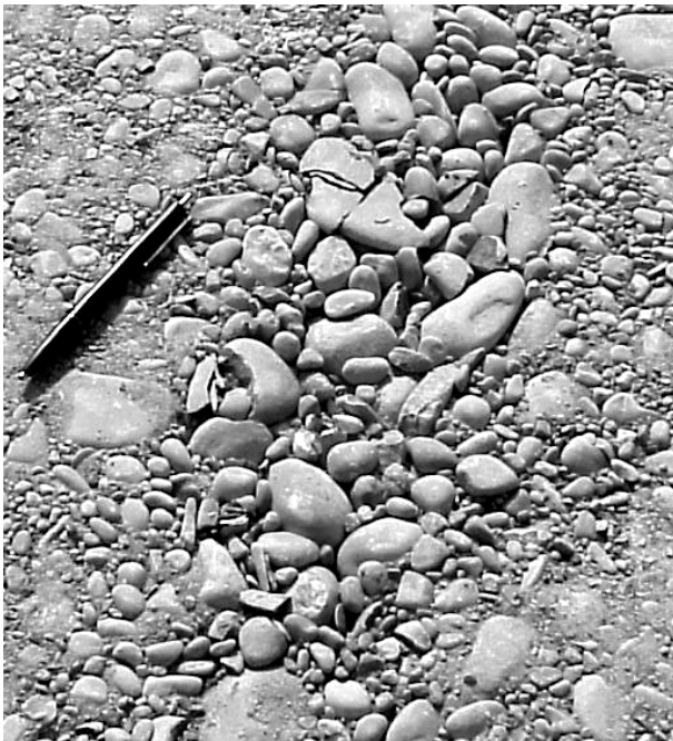
Abbildung 5-13: Oberfläche nach Ende der Verdichtung Spur Bomag.
