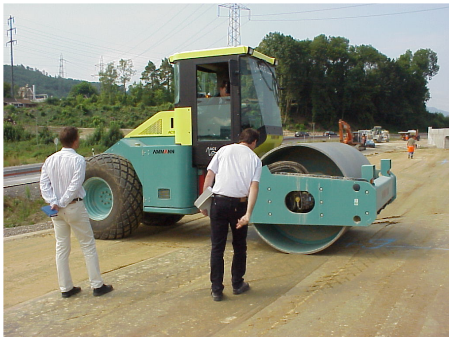
Abbildung A2-12: Messung der FDVK-Werte in Rheinfelden. Bei der Walze handelt es sich um einen Ammann Walzenzug AC 110-2.
