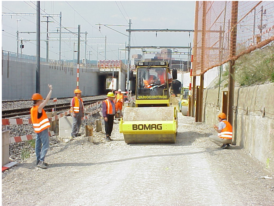
Abbildung A2-13: Bahnbaustelle am „Kohlendreieck“. Bomag Walzenzug 177DH-3 BVC.
