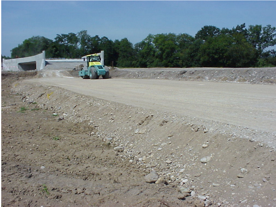
Abbildung A2-7: Kalkstabilisierte Dammschüttung der Strassenbaustellen in Rheinfelden.
