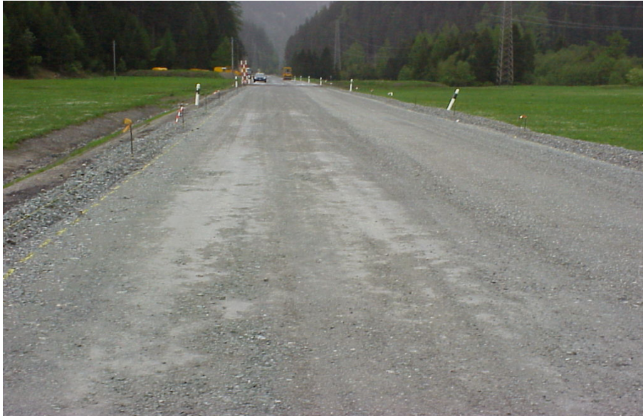
Abbildung A2-5: Prüffläche auf der Fundationsschicht bei der Strassenbaustelle in Rona. Material gut abgestufter Kies (GW), Kiessand I. Das Material wurde bei einem Wassergehalt w_n = \text{ca. } 0\% eingebaut und verdichtet.
