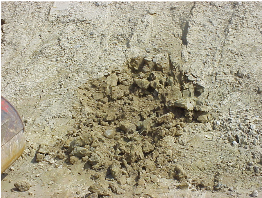
Abbildung A2-2: Material für die Dammschüttung in Teufen. Siltiger Sand ohne Kies (SM).
