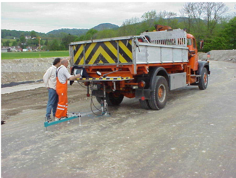
Abbildung A2-4: Statischer Plattendruckversuch auf der zementstabilisierten Foundationsschicht in Neuhaus.
