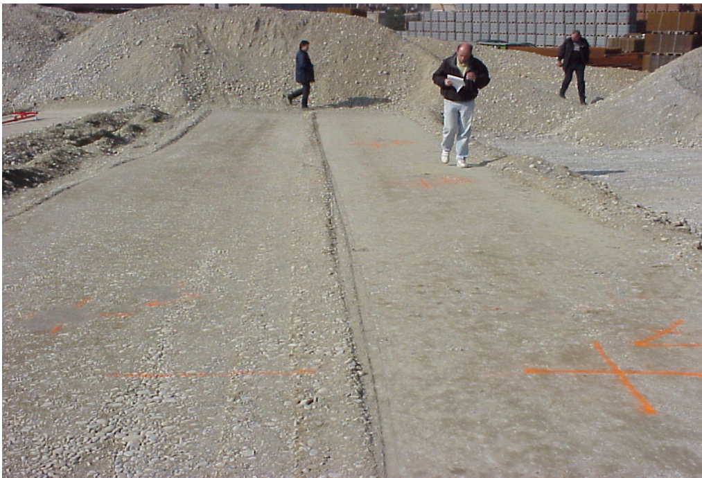
Abbildung A2-16: Versuchsfeld nach Abschluss der Messungen. Die rechte Spur wurde vom Walzenzug von Bomag bearbeitet, die linke von Ammann.
