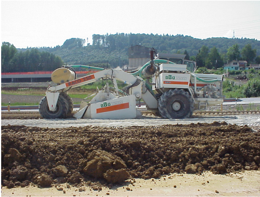
Abbildung A2-9: Mischen des Kalks mit dem Schüttmaterial.
