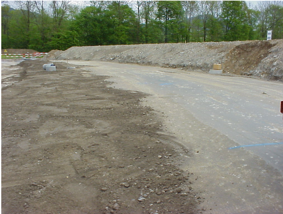
Abbildung A2-3: Prüffläche auf der zementstabilisierten Foundationsschicht der Strassenbaustelle in Neuhaus. Material siltiger Sand mit Kies (SM).
