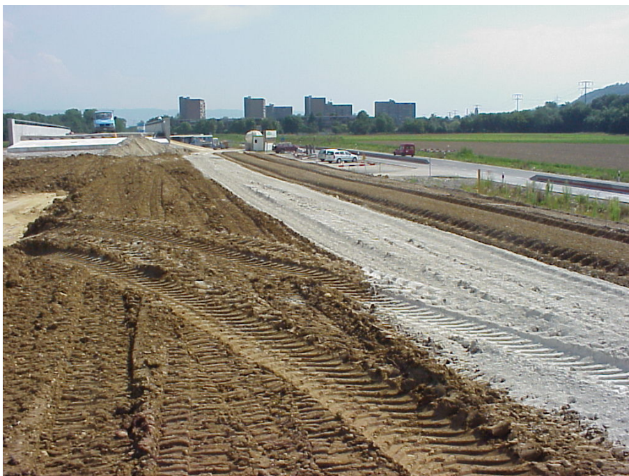
Abbildung A2-8: Verteilen des Kalkes für die Stabilisation.
