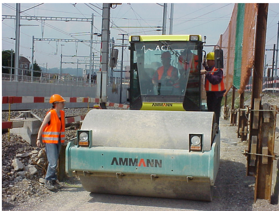
Abbildung A2-14: Bahnbaustelle am „Kohlendreieck“. Ammann Walzenzug AC 110-2.
