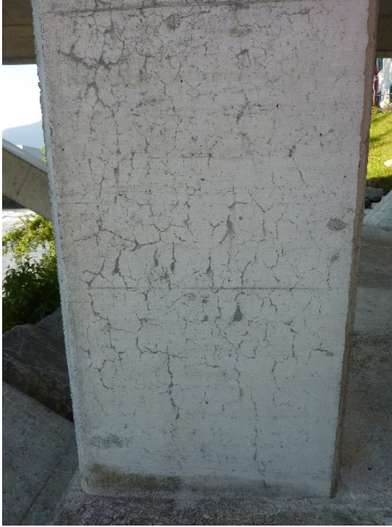
Stütze Seite Mastrils unterwasserseitig
