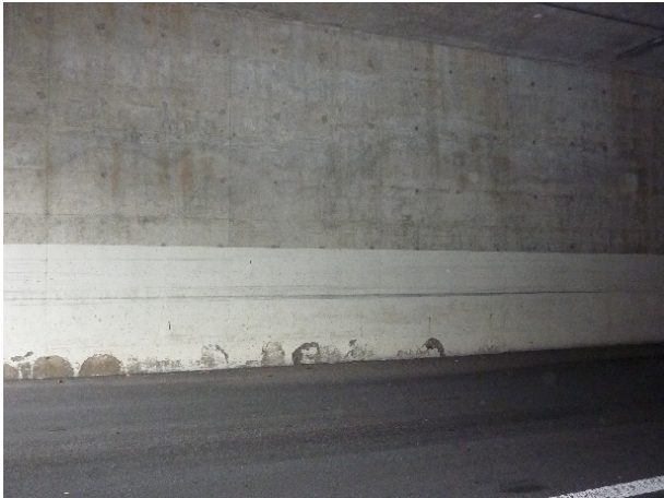
Wand Richtung Einigen
