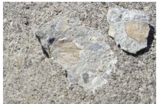
Abb. 33 Oberflächliches Absanden und Abplatzungen bei Kunstbauten im Kanton Zürich. Foto K. Lang, TBA Kt. Zürich, April 2014.
