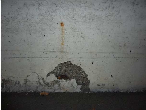
Wand Richtung Einigen
