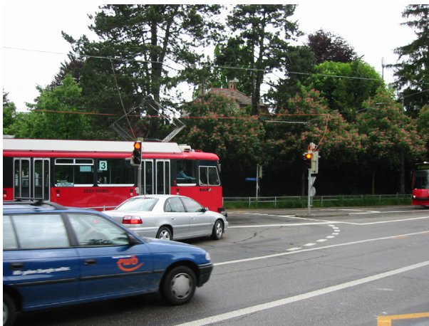
Kreisel Thunplatz (Bern, BE) Steuerung der Kreiseldurchfahrt und der Fussgängerquerung zur Mittelinsel
