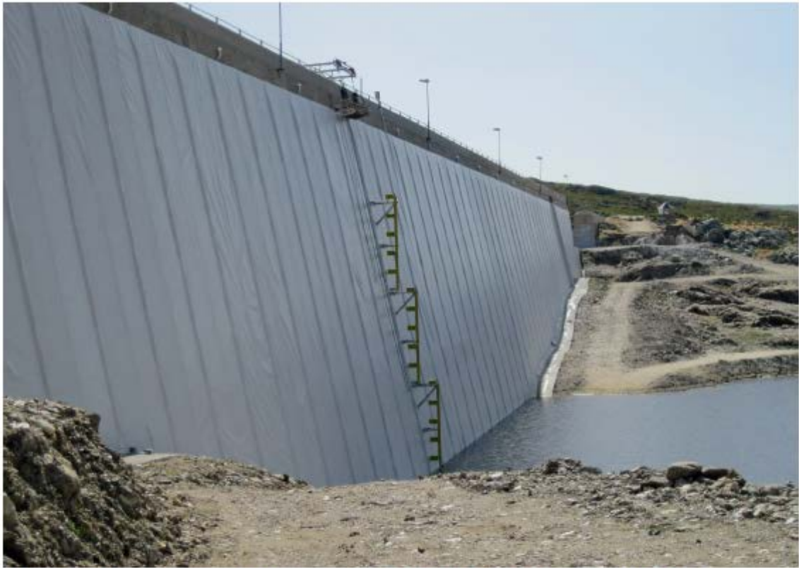
1 | Anwendung einer Kunststoffdichtungsbahn (KDB) bei einer Staumauer. Die unbedeckte Fläche ist ohne Schutzschicht (Foto: Sika AG).
