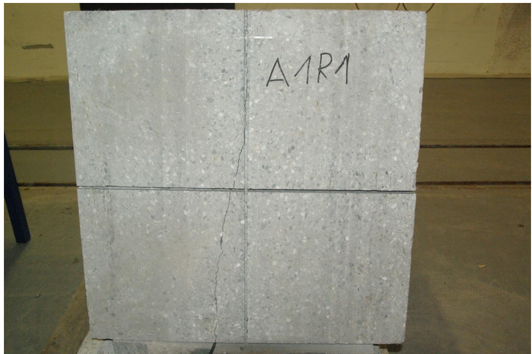
Abb.43 Faser 1 mit Rissverlauf ausserhalb der eingesägten Kreuznut
