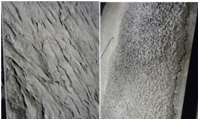
Abb.4 Kunstfelsimitation (Cheyenne_2_121G, Reckli AG, Schweiz) vor und nach der Spritzbetonapplikation (Wandgrösse 3.5 x 1.39 m).
