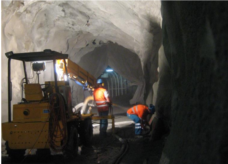
Abb.1 Spritzbetonapplikation und -prüfung
