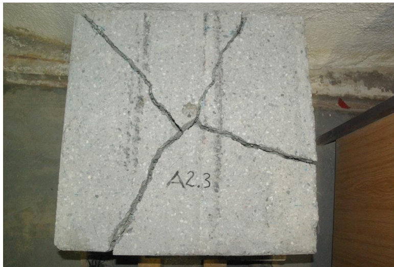
Abb.13 Typisches Rissbild an einer bis zu starker Deformation geprüften Kunststofffaserspritzbetonplatte
