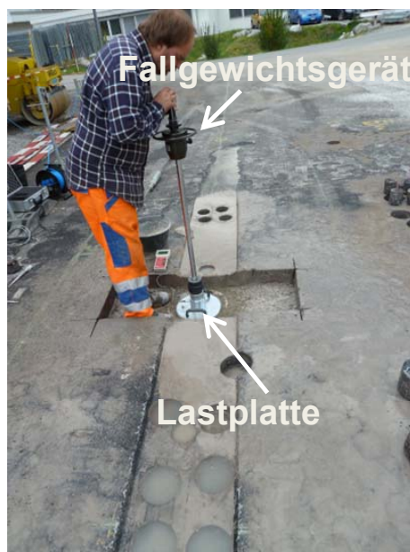
Abb. 14 LFG Messungen nach dem Test
