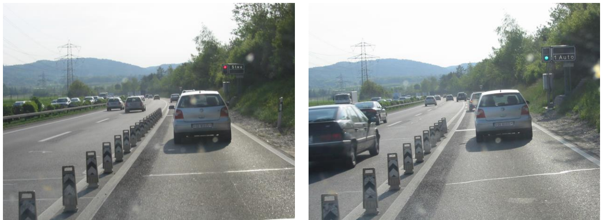
Abb. 2 Einfahrt mit Rampenbewirtschaftung
