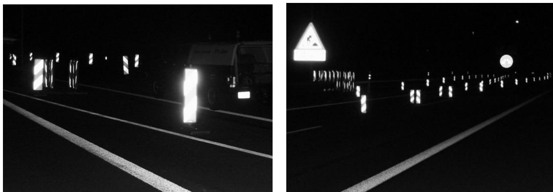
Abb. 7-7: Aufnahmen von Leiteinrichtungen bei Dunkelheit: links hohe Baken, rechts Leitschiene mit niedrigen Baken
