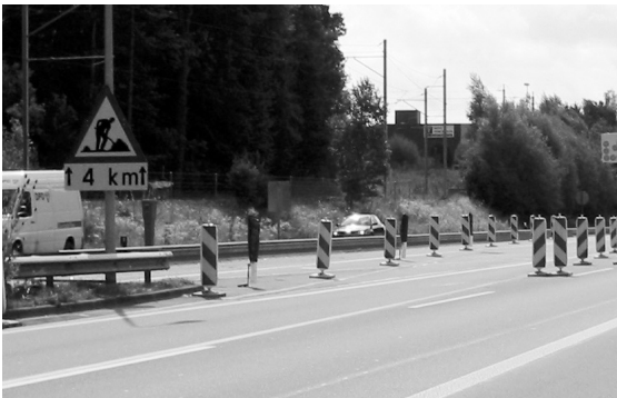
Abb. 2-4: Leitbaken im Grossformat in einstreifiger Mittelstreifenüberfahrt
