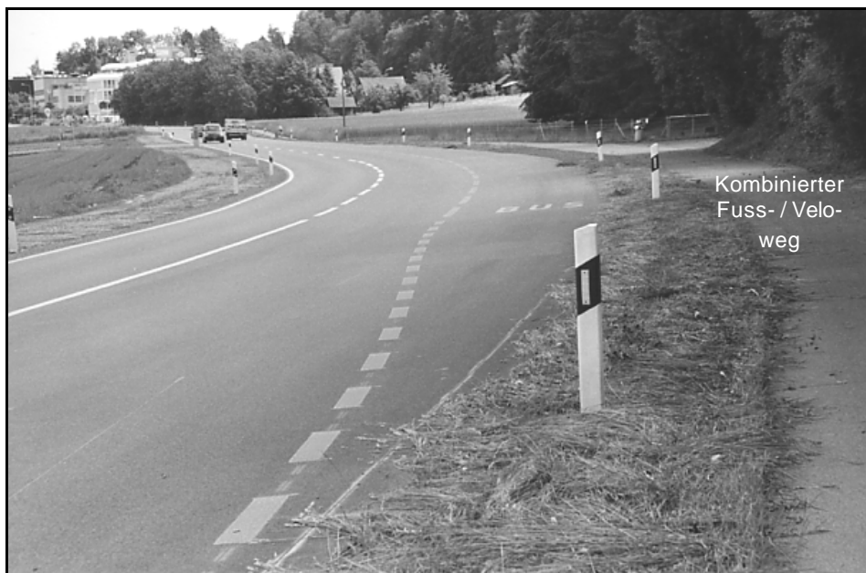
Figur 21 Beginn der 800 Meter langen Busspur von Dübendorf
