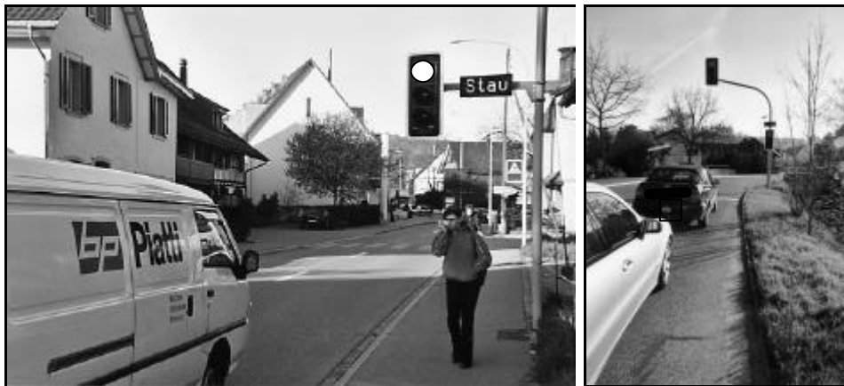
Figur 32 Dosieranlagen Stal-likoner- und Lielistrasse (bei letzterer ist der Text im Gegenlicht nicht lesbar)
