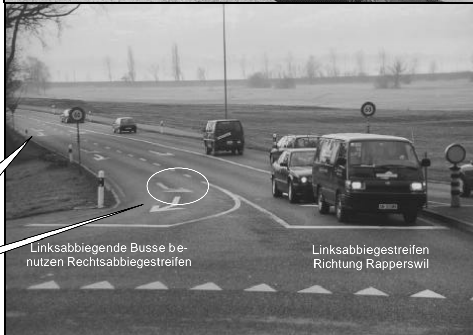
Figur 39 Knotenzufahrt von Süden: Die Staus auf dem Linksabbiegestreifen können von Linien- bussen auf dem Rechtsabbiege- streifen überholt werden.
