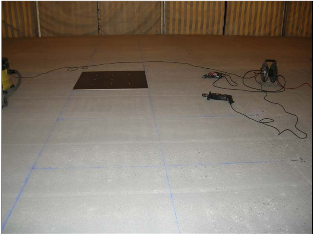
Abb. 13 Markierung der einzelnen Felder auf der Betonoberfläche
