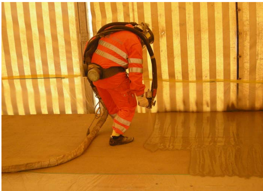
Abb. 9 Aufspritzen der Abdichtung aus Flüssigkunststoff FLK PU
