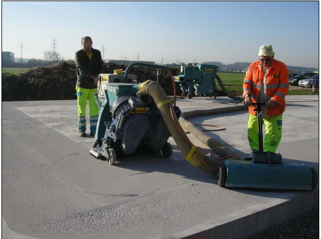
Abb. 6 Kugelstrahlen der Betonoberfläche
