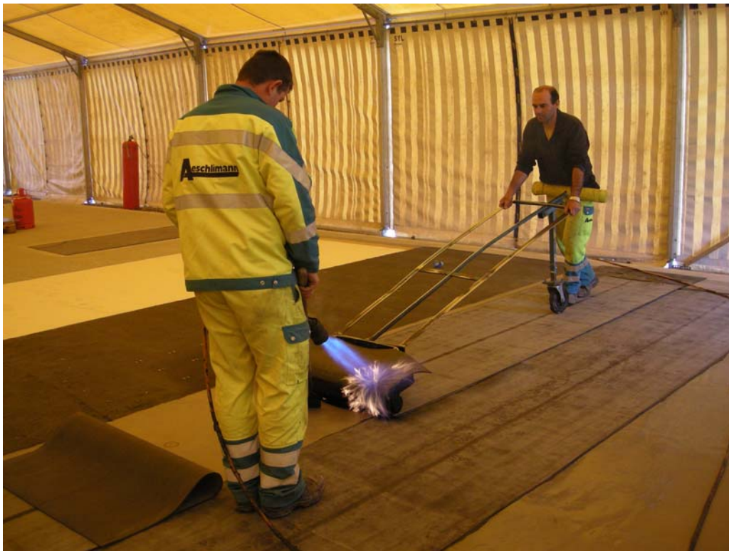
Abb. 10 Applikation der PBD-Abdichtung
