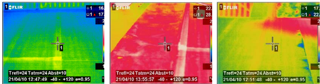
Abb. 40 Für die Ortung der Fehlstellen wurden in verschiedenen Feldern auch Detailaufnahmen erstellt. Die Bilder oben sind Ansichten aus der Testfläche 2 bei der Überlappung der Abdichtungsbahnen. Feld 2.2 (Bild oben links) und Feld 2.3 (Bild Mitte) und Feld 2.4 (Bild rechts).
