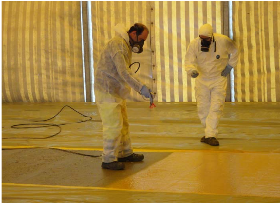
Abb. 11 Aufspritzen der PMMA-Flüssigkunststoff-Abdichtung
