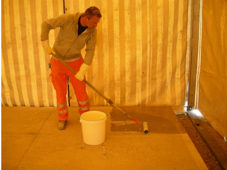
Abb. 8 Applikation der Epoxidharz-Grundierung mit Lammfellroller
