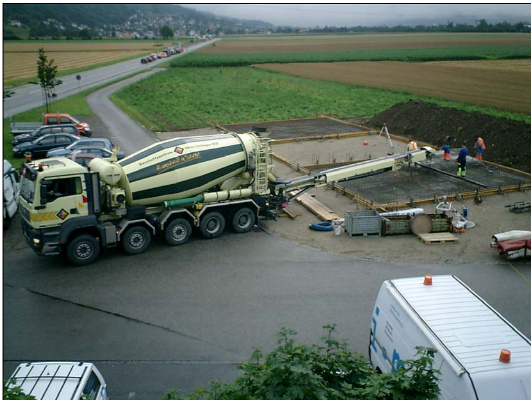
Abb. 5 Betonarbeiten der Platte 1
