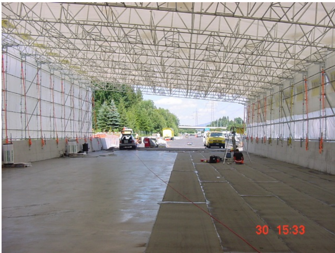
Abb 60 Bünztal-Viadukt im Bauzustand
