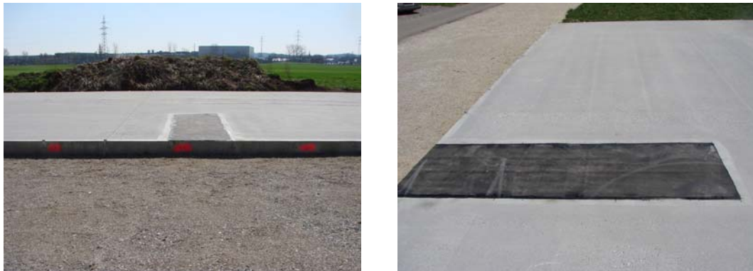
Abb. 32 Vorversuch bei dem unter der PBD-Abdichtung Fehlstellen erstellt wurden.
