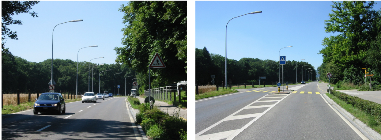
Abbildung 10: Situation Fussgängerübergang Wehntalerstrasse; Zufahrt Zürich
