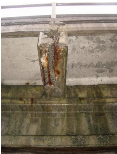
Abb. 3 Abplatzung Konsolkopfträger
