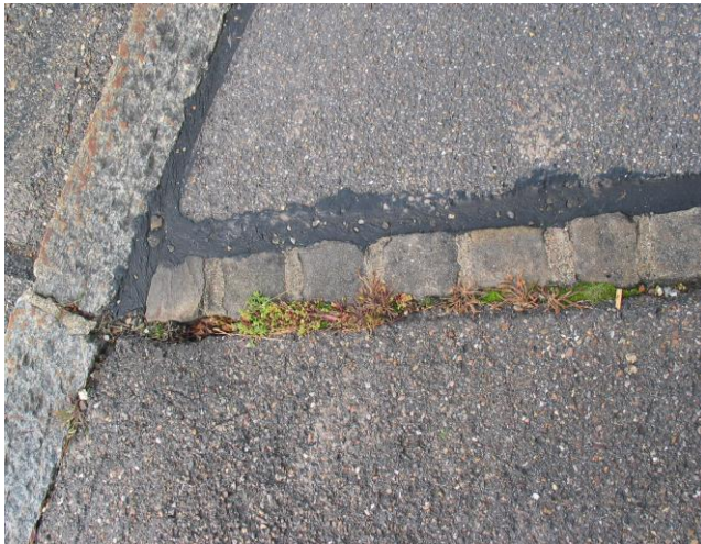
Abb. 20 Belag/ Fugen Gehweg
