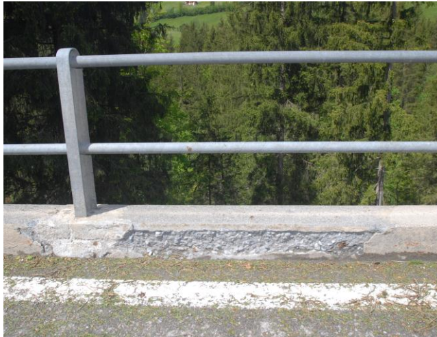
Abb. 4 Abplatzungen Konsolkopf
