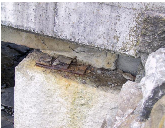
Abb. 25 Korrodiertes Lager
