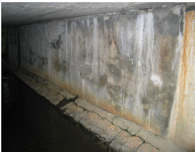
Abb. 21 Ansicht Widerlager Seite Hausen
