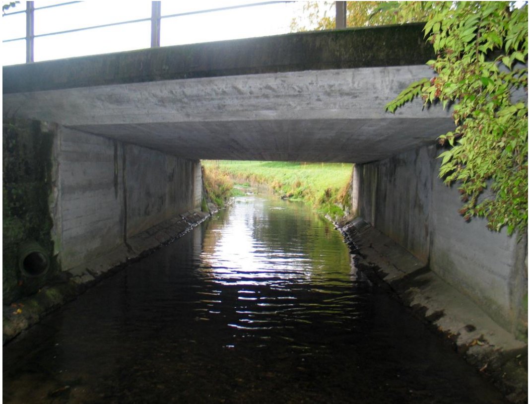
Abb. 19 Übersicht Brücke unterwasserseitig
