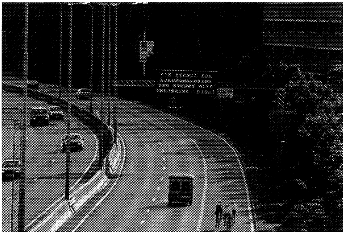
Figure 13 : Panneaux à messages variables donnant l'information d'une fermeture de tunnel et des itinéraires à choix à Oslo.
