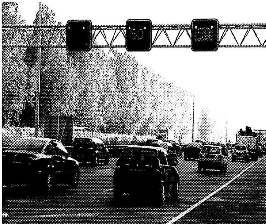
Figure 10 : Avertissement de bouchon entièrement automatique avec des signaux variables de vitesse aux Pays-Bas.
