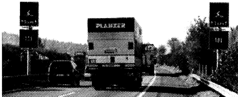
Figure 2 : Exemple de signaux à fibres optiques utilisés au Grauholz.
