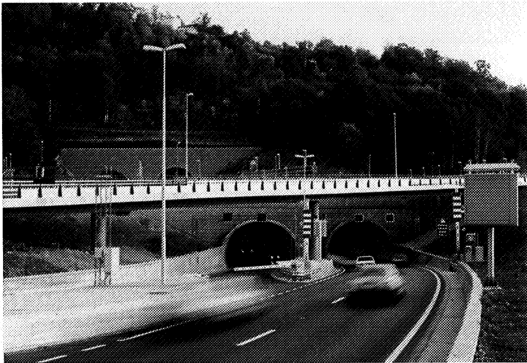
Figure 12 : Les signaux à prismes et les feux d'affectation des voies sont utilisés pour les tunnels à Oslo.
