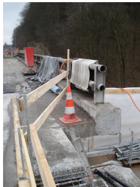
Abb. 4.73 Trennschnitt (Mitte) und Betonabbruch mit Hochdruckwasserstrahlen zur Wiederverwendung der Querbewehrung (links unten)
