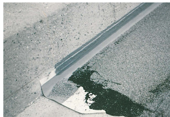
Abb. 4.40 PBD-Wärmeschutz auf dem PVC-Fugenband, mit Schieferplättchen abgestreut
