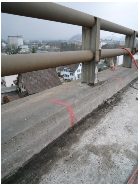
Abb. 4.72 Bereich Konsolkopf nach Belagsabbruch (Fahrrichtung Zürich)
