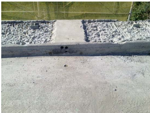
Abb. 4.64 Bohrkern-Entnahmestellen 2011
