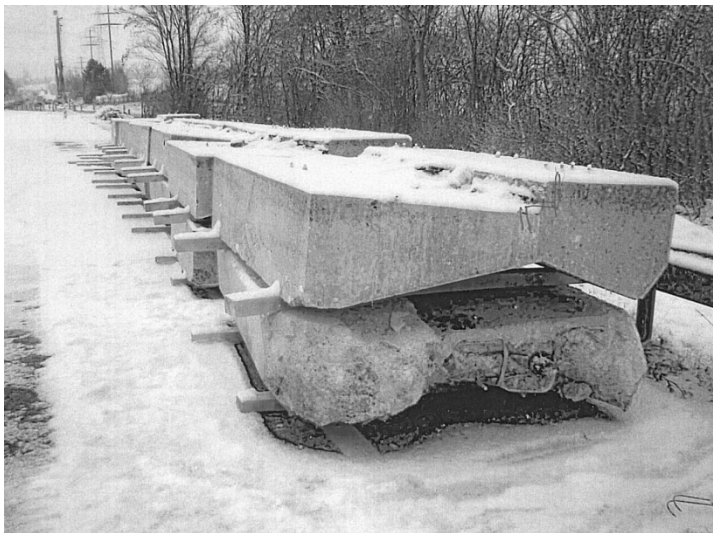
Abb. 4.53 abgetrennter Konsolkopf
