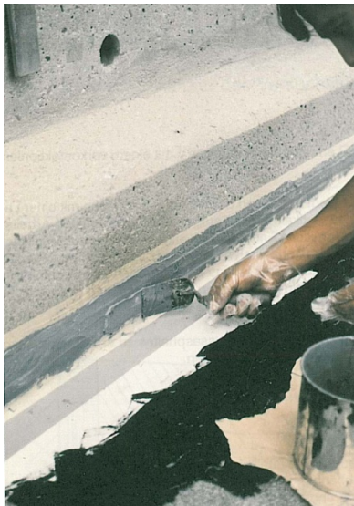
Abb. 4.39 Befestigung epoxidseitiges Vlies mit 2-Komponenten-Mörtel
