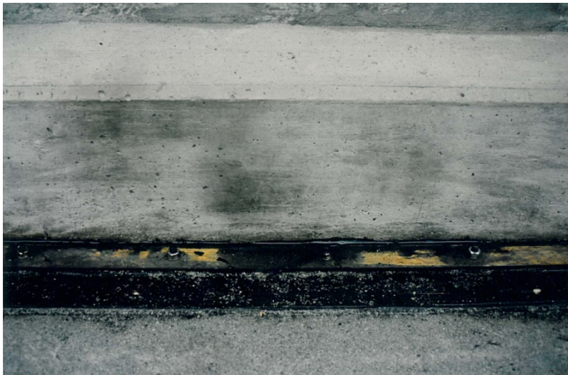
Abb. 4.26 Fertig applizierte Abdichtung und montierter Flachstahl
