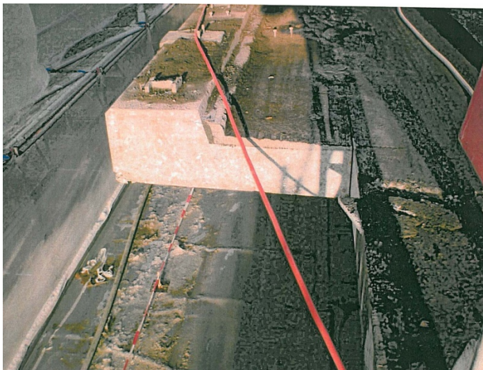
Abb. 4.50 Trennen des Konsolkopfs für die Verbreiterung der Lorzentalbrücke
