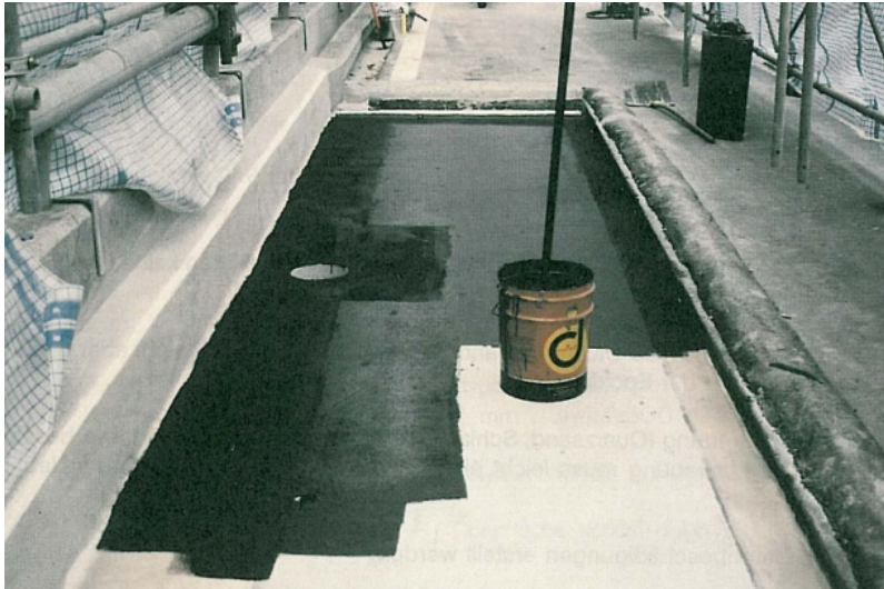
Abb. 4.36 Applikation Grundierung auf Bitumenbasis zur Haftvermittlung mit PBD-Abdichtung
