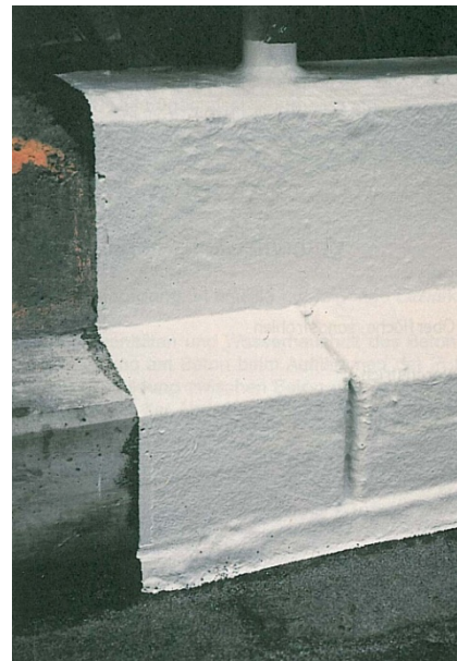
Abb. 4.44 2. Schicht GFK-Polyester über PBD-Aufbordung gezogen
