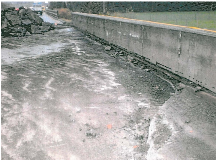
Abb. 4.47 Belagsabbruch und Entfernen der vollflächig verklebten PBD-Abdichtung, stumpf angeschlossen mit Polymerbitumen-Verguss
