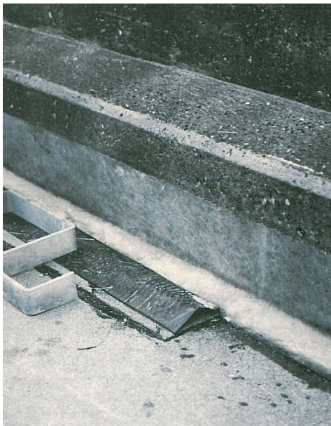
Abb. 4.43 1. Schicht GFK-Polyester auf Fahrbahnplatte und Brüstung aufgetragen, PBD-Längsstrei- fen in nicht ausgehärteten GFK verlegt
