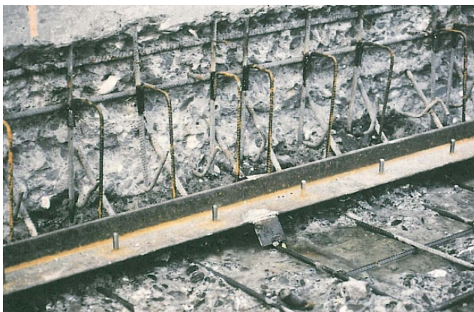
Abb. 4.22 An die Bewehrung befestigter Stahlwinkel LNP vor dem Reprofilieren der Brüstung und der Fahrbahnplatte
