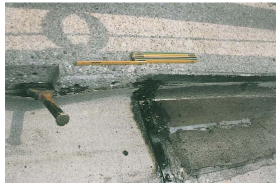
Abb. 4.65 hochgezogener PBD-Abdichtungstreifen als Randverklebung
