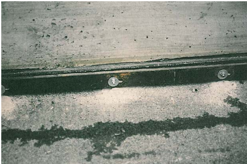
Abb. 4.32 Fertig versetzte Klemmschiene an Betonbrüstung geschraubt
