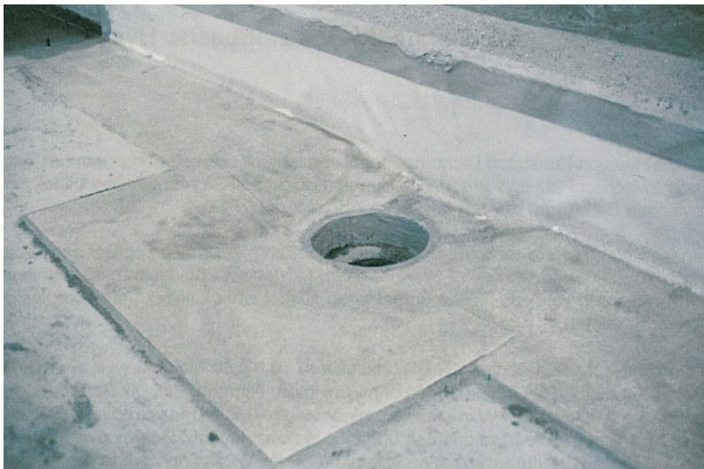
Abb. 4.35 1. Schicht Hypalon-Kunststoffdichtungsbahn verlegt, mit Quarzsand abgestreuter Mörtel
