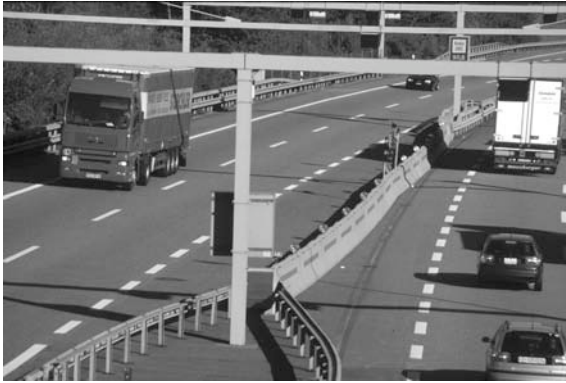
Bild 13, System mit anschliessender Verzweigung A3, Kanton Aargau
