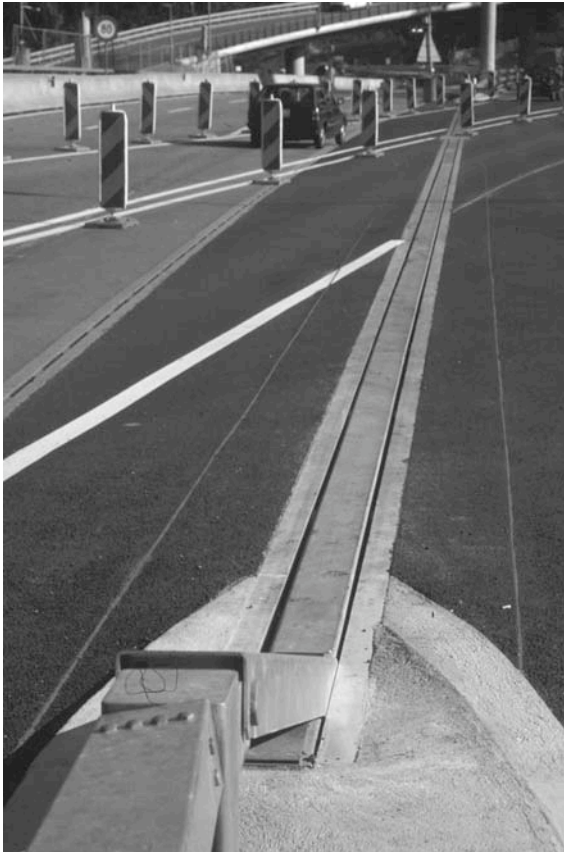
Bild 20, System Burri mit Verbindung zur anstossenden Leitschranke, A3, Standort Entlisberg
