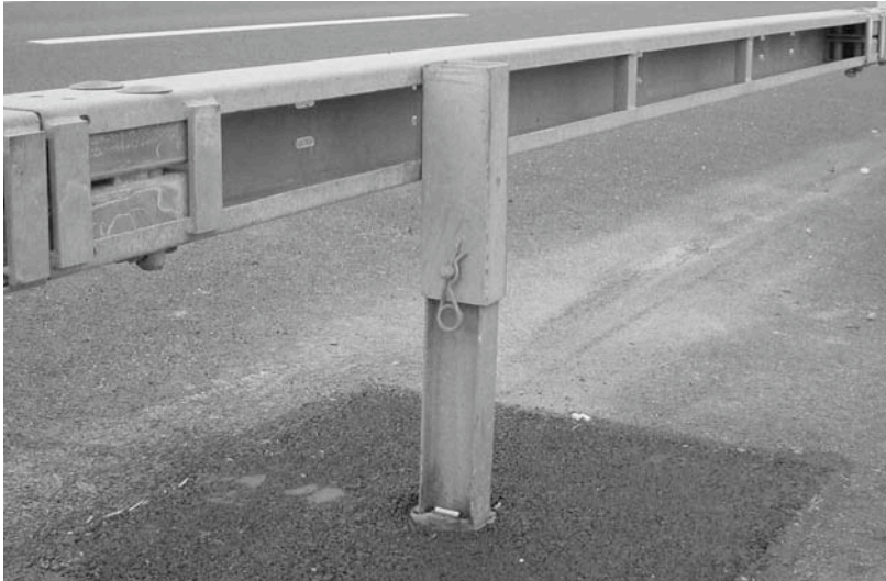
Bild 6, Schnell demontierbare Leitschranke mit seitlich offenem Kastenprofil 150/180 mm
