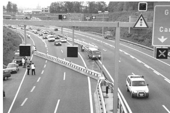
Bild 10, System Scholl-Metall bei der Inbetriebnahme (Foto Scholl-Metall)
