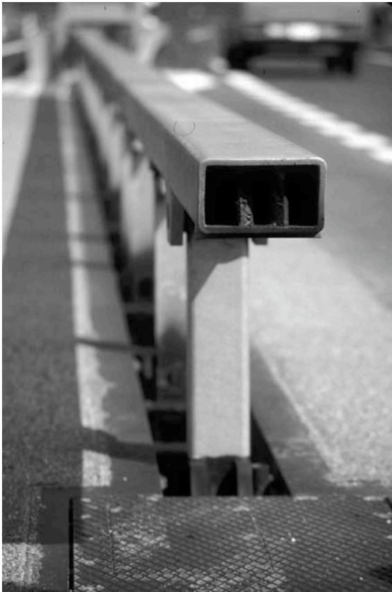
Bild 17, System Burri, Kastenprofil mit Pfosten, vor dem Gubristtunnel, A20, Kanton Zürich (Aufnahme 1985)
