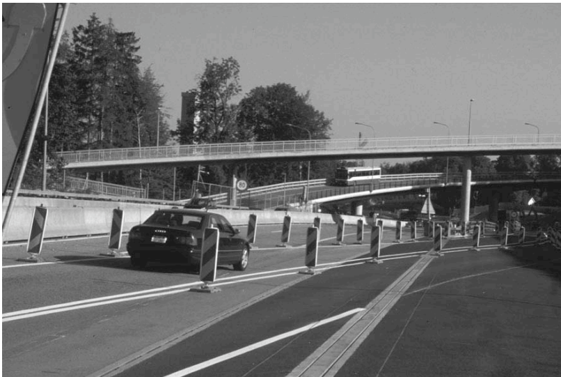
Bild 19, System Burri abgesenkt, vor der Überdeckung Entlisberg, A3, Kanton Zürich
