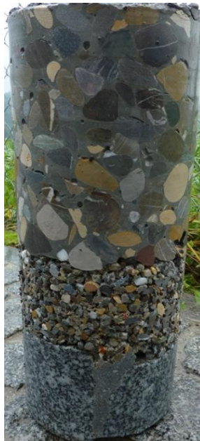
Abb. 1 Foto Bohrkern Feld 8.2.2.2 mit dem homogenen Drainbeton
