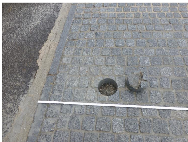
Abb. 53 30.09.2013, Bohrkern Nr. 8.1.2.1
