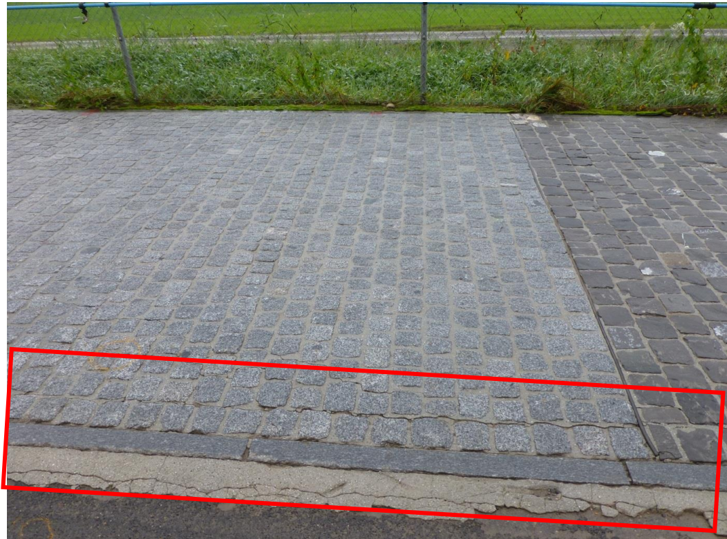
Abb. 44 Feld 8.1.1, am 30.09.2013 im Rissbereich zum Anschluss an den Asphalt
