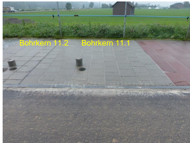
Abb. 116 Feld 11, am 30.09.2013, Bohrkern 11.1 und 11.2
