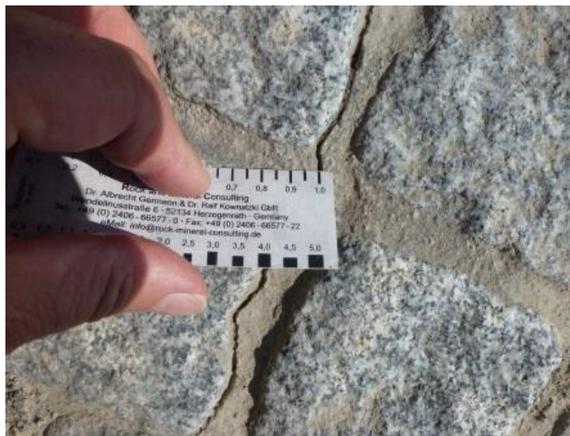
Abb. 72 Feld 8.2.2, am 28.05.2013 mit dem 1 mm breiten Riss
