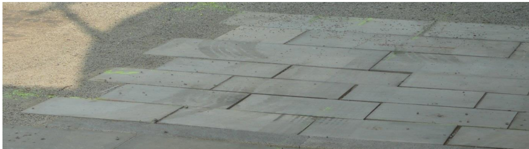
Abb. 157 MLS Feld 4.2, Fotoausschnitt mit den Absätzen zwischen den Platten
