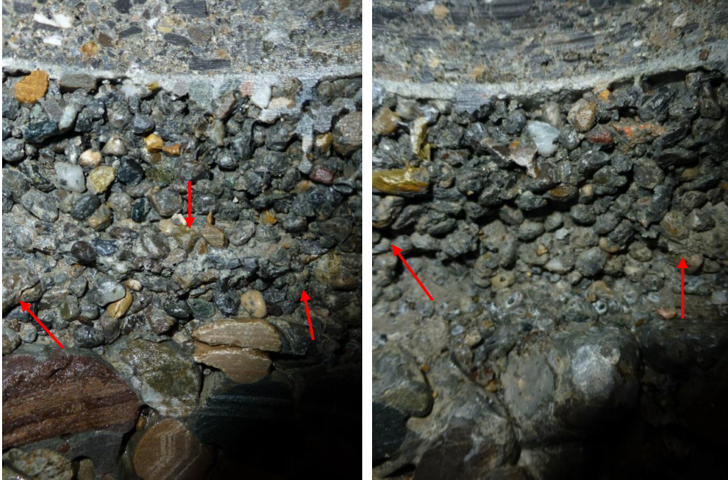
Abb. 94 und Abb. 95 Bohrwand Nr. 9.1.1, vom 30.09.2013
