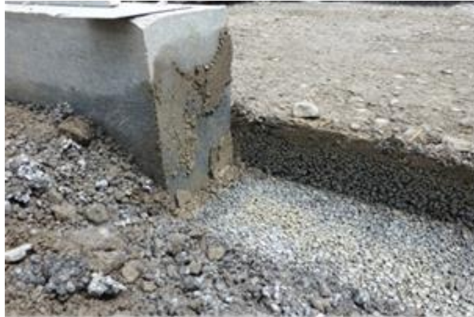
Abb. 20 Monokornbeton des Bordsteins
