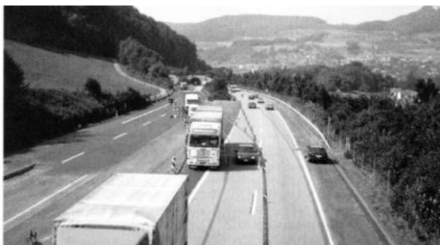
Figur 11 Provisorische Über-leitung zweisepurig „Ebenrain“ während der Belagserneuerung auf der A2
