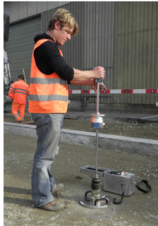
Fallen des Fallgewichtes
