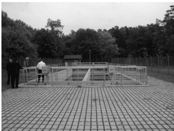
Figure 15 : Station pour déchlorurer l'eau avec les deux réservoirs (Photos : W. Bollinger)
