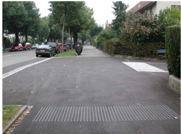
Abb. 8.49: Aufmerksamkeitsfeld auf einer Trottoirüberfahrt in Basel, aufgebracht in schwarzer Farbe und ohne verbindende Leitlinien. (Foto: Barbara Auer)
