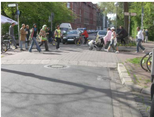
Abb. 10.51: Vertikalversatz im Streckenbereich (Foto Carola Bachmann)
