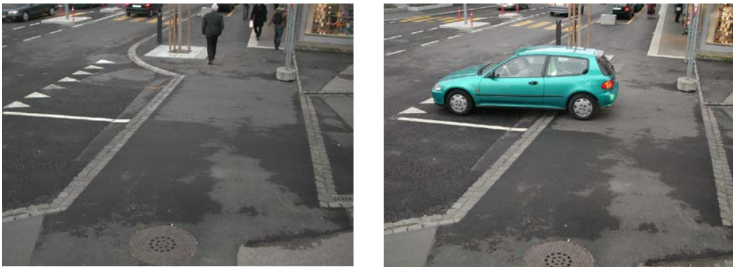
Abb. 8.33: Nicht zulässig: Verschiebung vorderer Rand der Trottoirüberfahrt nach hinten
