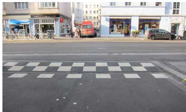
Abb. 8.42: Gut erkennbare Anrampung mit Schachbrettmuster
