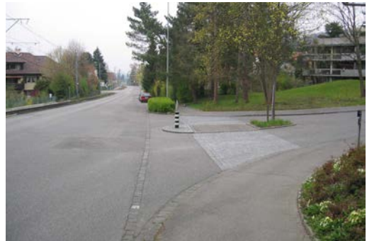
Abb. 10.63: Mittelinsel im Einmündungsbereich
