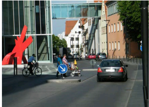
Abb. 10.64: Mittelinsel auf Mehrzweckstreifen (Quelle: bfu 2011)
