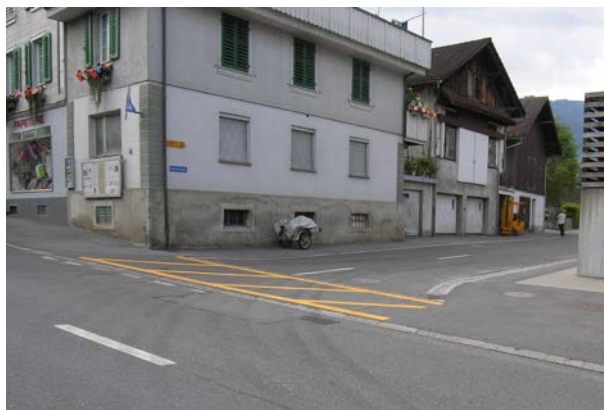
Abb. 8.45: Trottoirüberfahrt mit Fussgängerlängsstreifen ist rechtlich nicht zulässig (Foto: Walter Bill)
