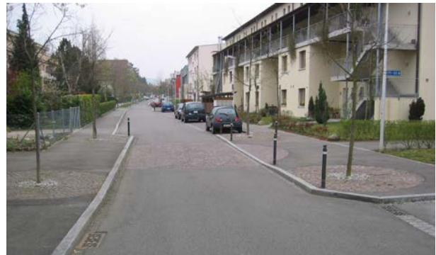
Abb. 12.77: Baulich ausgeführte Trottoirnase mit Pfosten gesichert
