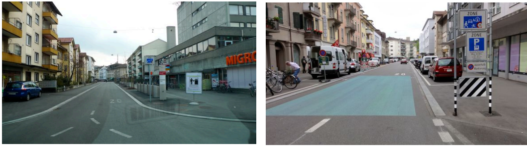
Abb. 7.3 und 7.4 Bern Mittelstrasse vorher und nachher. Rechts: Verbessertes Eingangstor West mit tieferem Signal und Farbgestaltung.
