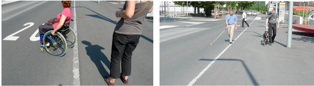
Abb. 5.30 und 5.31 Die Begegnungszone im Ortskern von Bremgarten ist ein gutes Beispiel für die Abtrennung des weitgehend den Fussgängern vorbehaltenen Raumes und der Fahr-Verkehrsfläche. Ein schräggestellter Randstein erlaubt das taktile Erfahren mit dem Taktstock ohne das Überfahren mit dem Rollstuhl oder Rollator einzuschränken. Zu beachten gilt allerdings: Die klare Unterscheidung von Fahrbahn und Randbereich hat unter Umständen zur Folge, dass die Geschwindigkeit schlechter eingehalten wird, da eine solche Gestaltung eher zu schnellerem Fahren animiert.
