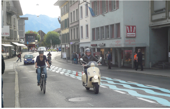
Abb. 8.2 Flächiges Querensystem in Thun; Die blauen Wellen dienen als Mittelzone. Das V85 im Regime „generell 50 innerorts“ liegt tagsüber bei 25km/h und der Schnitt über 24 Stunden bei 30km/h. Die durchschnittliche Durchfahrtszeit der Motorfahrzeuge und die Wartezeit der Fussgänger sind gesunken. Pro Jahr entfallen Kosten von rund Fr.200'000.- für hinfallige Verkehrsdienste.
