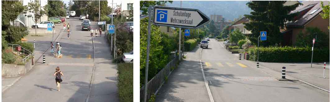
Abb. 5.12 und 5.13 Tempo-30-Zone Schlieren Köniz mit vertikalem Versatz beim Schulsehauseingang. Der im Bild noch sichtbare Fussgängerstreifen wurde unterdessen nicht mehr erneuert, weil er unzweckmässig ist.
