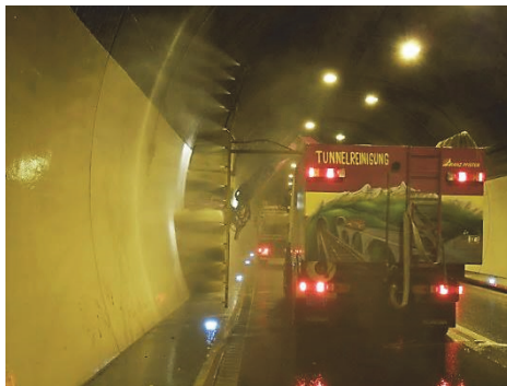
Abb. 4.50 Tunnel Flüelen – 12.04.2012, Hochdruckreinigung.
