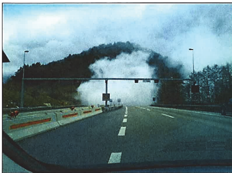
Abb. 4.47 Tunnel Bözberg - 16/06.2012, Turboschaden und Ölverdampfung
