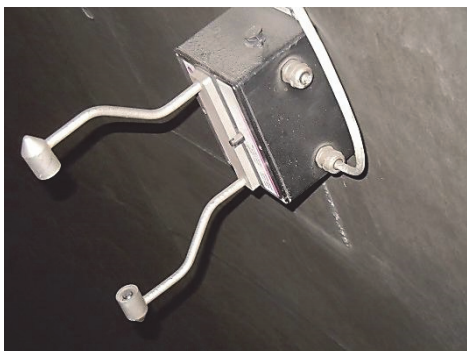
Abb. 4.39 Tunnel Bözberg - FIV, Verschmutzungsspuren
