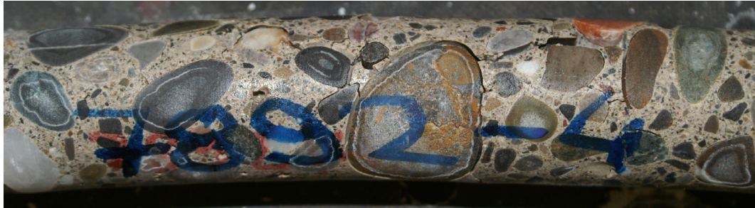
Abb. 4.43 Bohrkern mit einer Dehnung von > 10\text{‰} nach Ende der Sulfatwiderstandsprüfung mit ausgeprägter Rissbildung.
