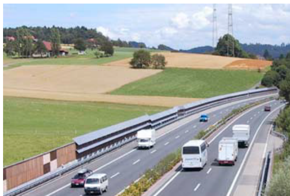
Abb. 1.7: Schindelanlage an der A2 bei Safenwil
