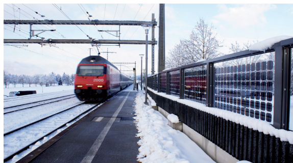
Abb. 7.3: Integrierte bifaciale Photovoltaik-Schallschutzanlage in Münsingen
