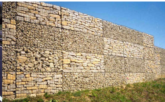
Abb. 1.2: Steingabionen als Lärmschutz
