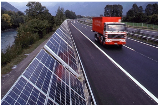
Abb. 1.1: PV-Schallschutzanlage
