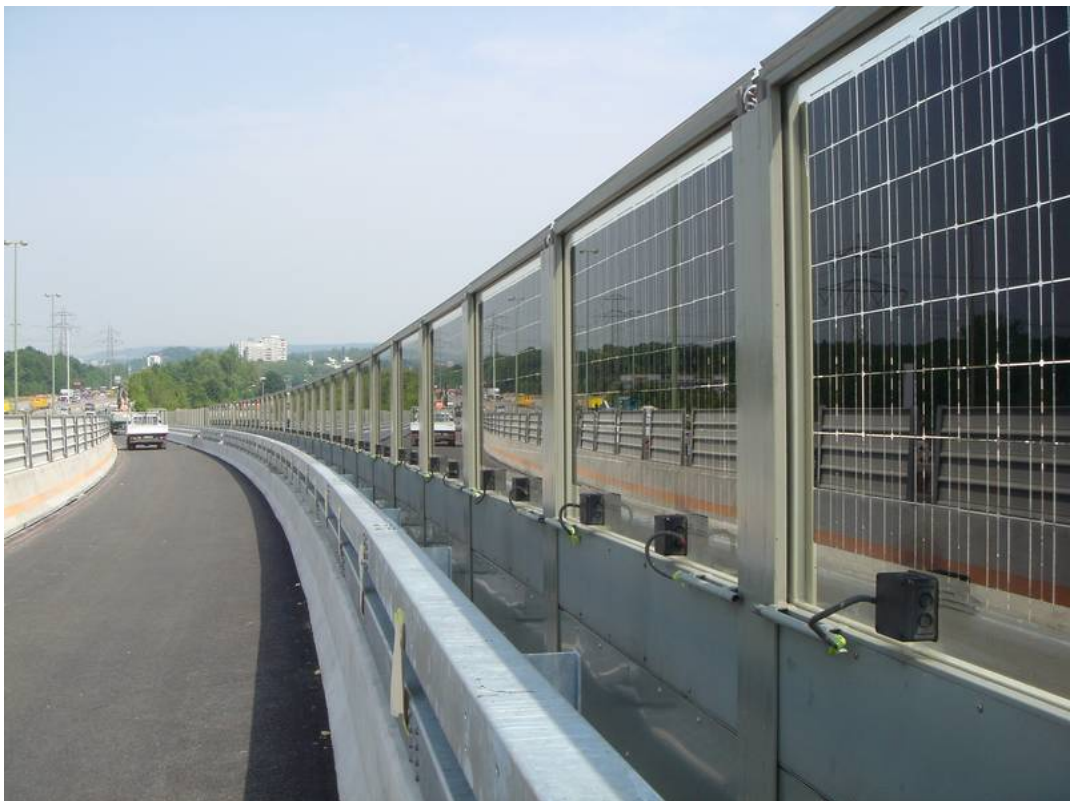
Abb. 3.7: Beispiel einer bifacialen PV Anlage entlang der N1 in Aubrugg Kanton Zürich. Die strassenzugewandte Seite entspricht der Westseite.
