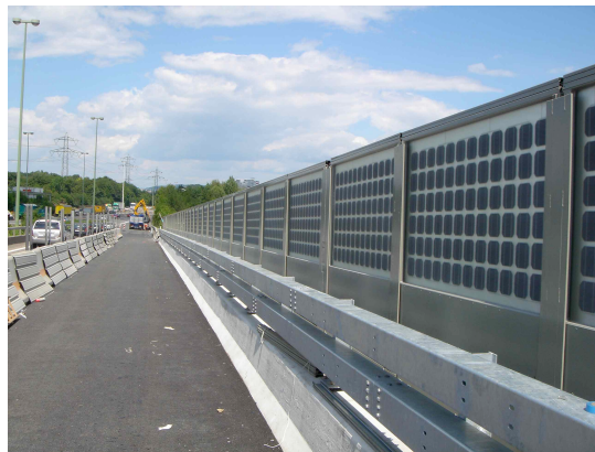
Abb. 1.12: Typ Bifacial entlang der Autobahnüberführung in Zürich
