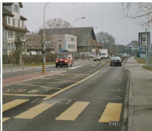
Abb. 2.3 Mittelfahrbahnhaltestelle in Cham [Q: Metron]
