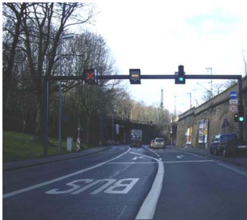
Abb. 2.5 Nördl. Ende E-Busspur in Mainz [Q: Google Street View]
