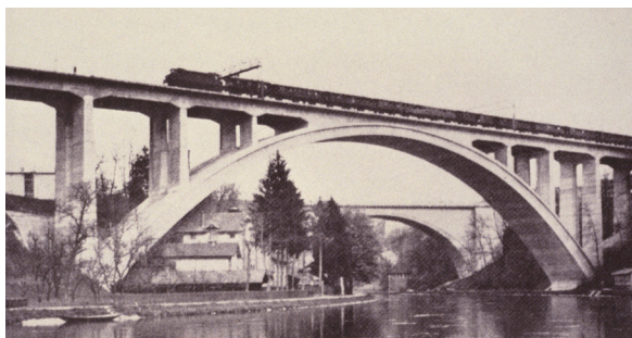
Bild 13 SBB Lorraine-Brücke in Bern
