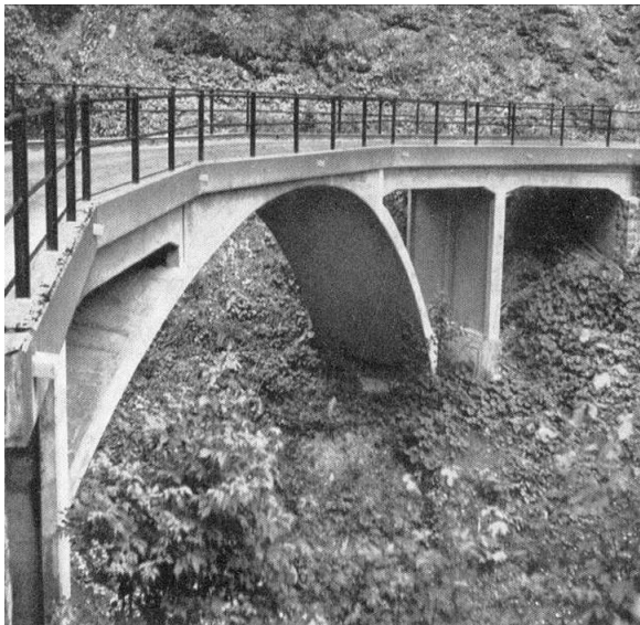
Bild 21 Ziggenbach-Brücke, Wägital, SZ
