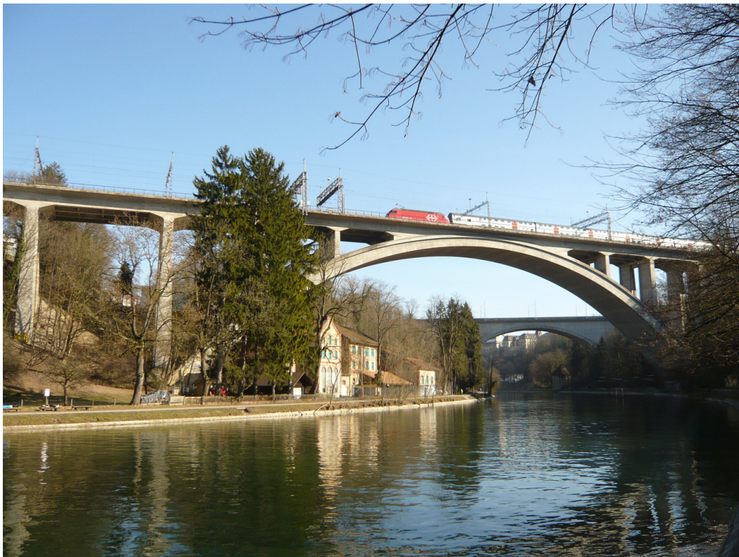
Bild 33 SBB Lorraine-Brücke, Bern
