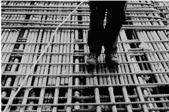
Bild 50 Bewehrung eines Endquerträgers einer Schrägkabelbrücke in den USA, dessen volle Tragfähigkeit für die Standsicherheit der ganzen Brücke erforderlich ist.
