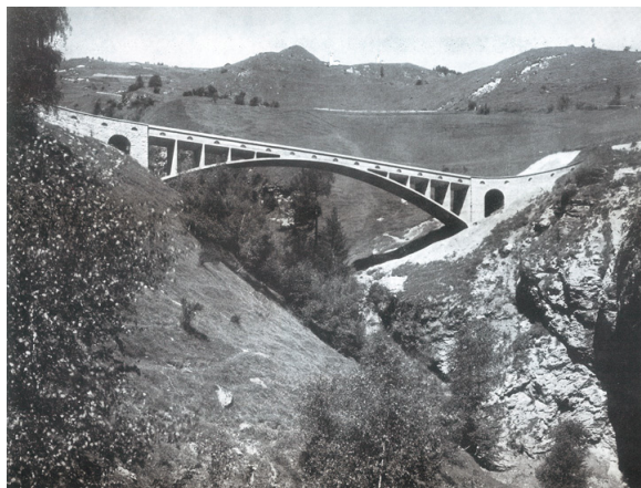
Bild 27 Val Tschiel-Brücke, GR
