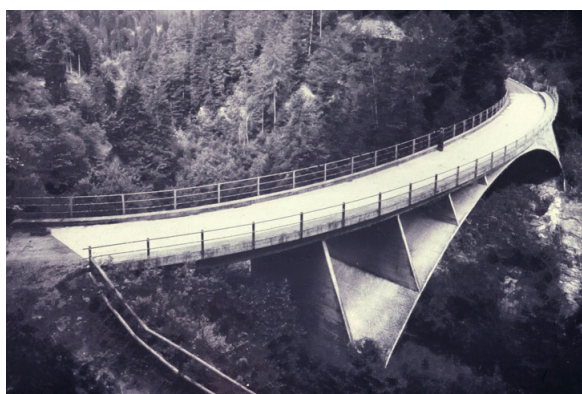
Bild 23 Schwandbach-Brücke bei Hinterfultigen, BE
