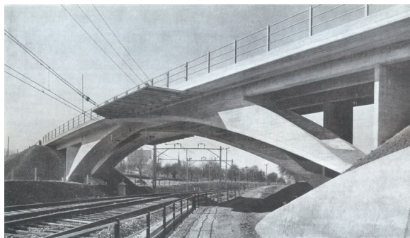
Bild 28 Strassenüberführung bei Lachen SZ
