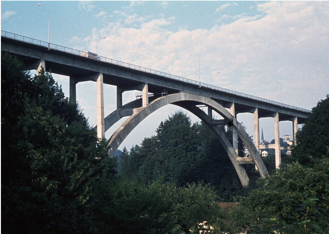
Bild 31 Fürstenland-Brücke in St. Gallen
