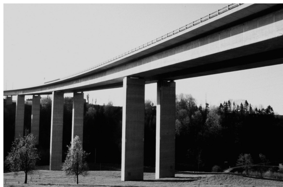
Bild 43 Goldach-Brücke der A1, SG
