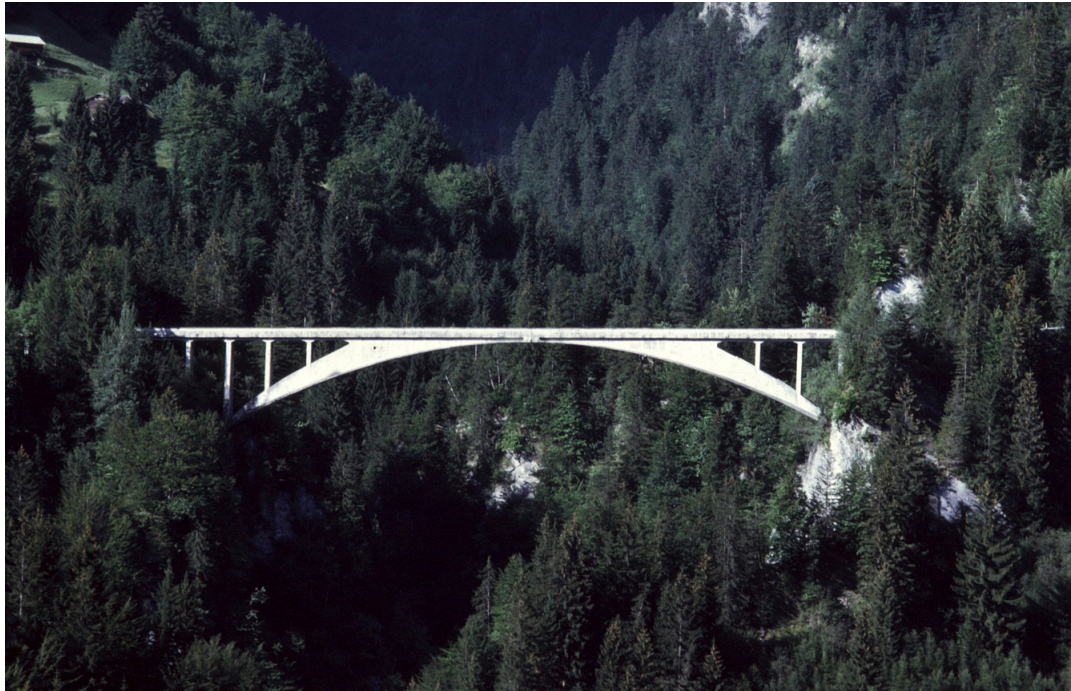
Bild 24 Salginatobel-Brücke bei Schiers, GR
