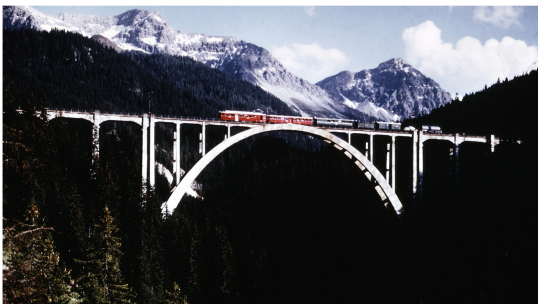
Bild 16 Langwieser-Viadukt der Chur-Arosa-Bahn, GR
