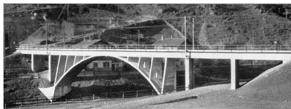
Bild 9 Landquart-Brücke der RhB in Klosters
