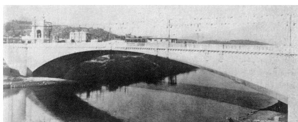
Bild 7 Risorgimento-Brücke in Rom
