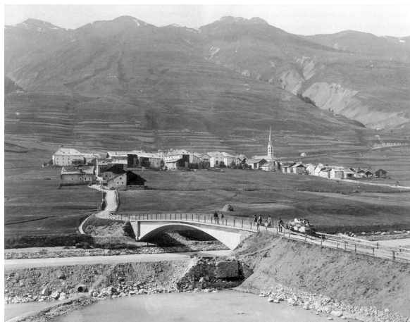
Bild 6 Inn-Brücke bei Zuoz
