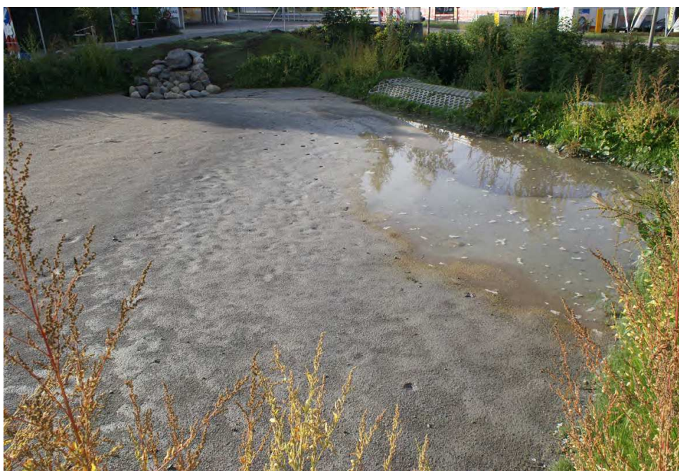
Fig. 11.19 Bassin de rétention-filtration avec filtre en sable
