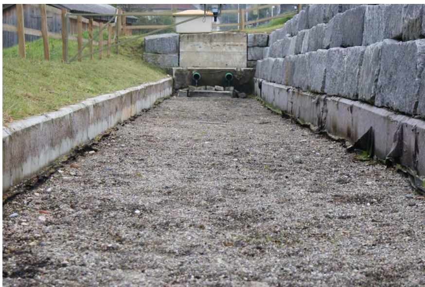
Fig. 13.23 RFB avec filtre splitt (Oberdorf)
