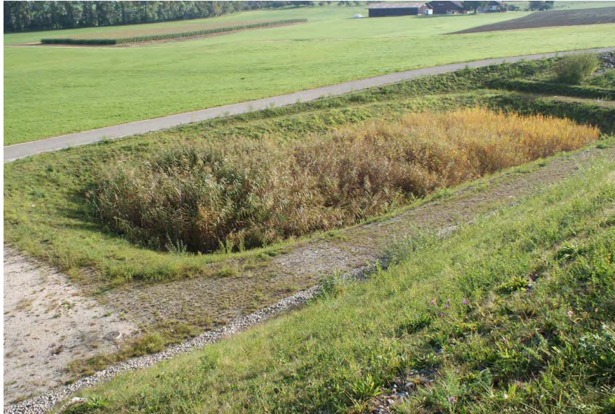
Fig. 12.21 RFB avec filtre en sable et roseaux
