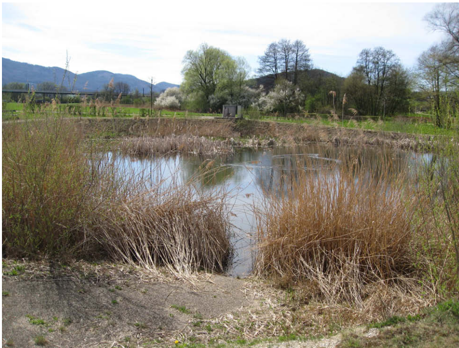
Fig. 8.12 Bassin de rétention à lame d'eau permanente (A16, Delémont Ouest)
