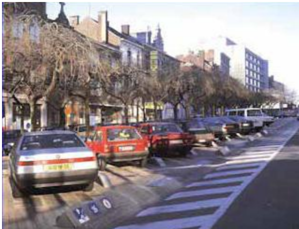
Abb. 3.11 System Vigiville in Charleroi (B) (Quelle: www.inec.fr/Presentation/EurStat.htm )
