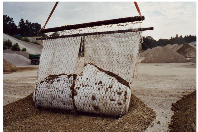
Abb. 66 Ausbau Geokunststoffe im Schotter.
