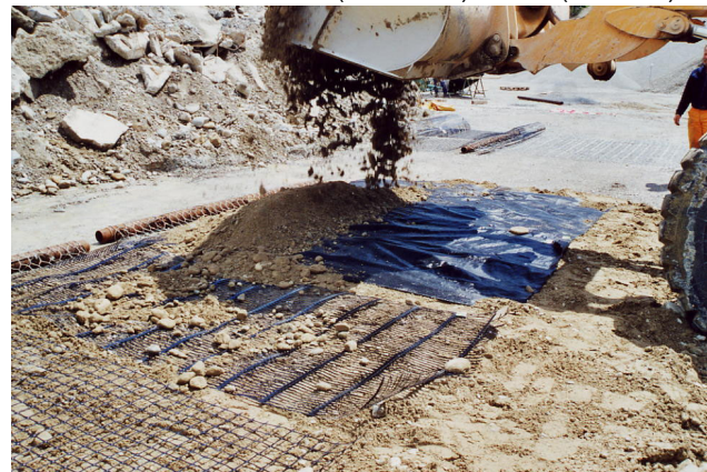
Abb. 62 Aufbringen der 2. Schüttung (Wandkies).
