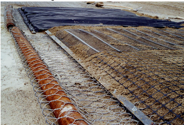
Abb. 61 Auslegen der Geokunststoffe auf 1. Schüttung.
