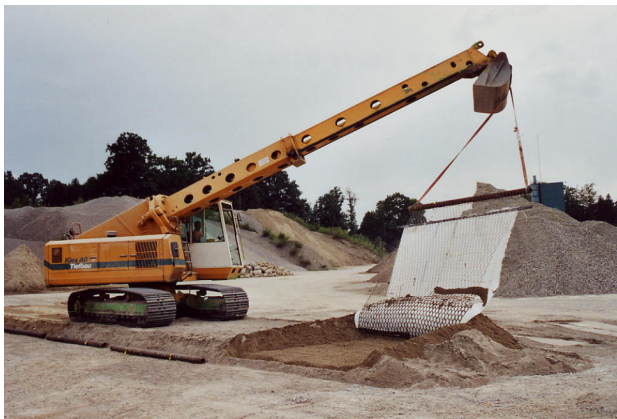
Abb. 65 Ausbau Geokunststoffe im Sand.
