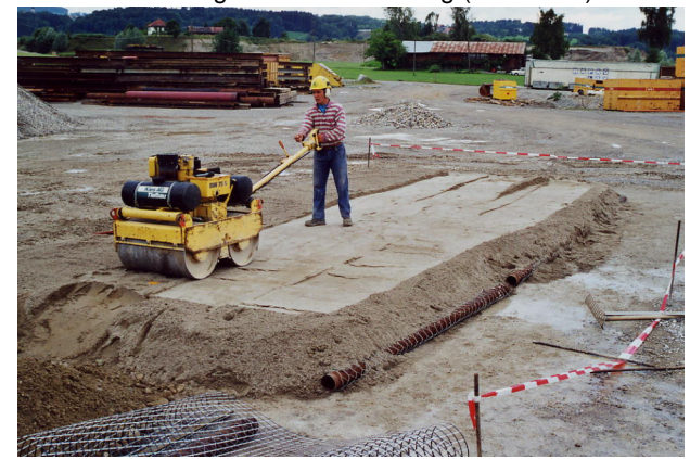
Abb. 64 Verdichtung (Feld I, Sand).
