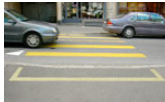
Abb. 4.38 Beispiele aus dem Ausland sowie Versuchsanordnung TCS Lausanne: markierte Kopfelemente im Halteraum
