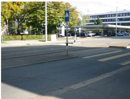
Abb. 4.39 Anordnung und Markierung von Fussgängerstreifen bei Strassenbahnen
