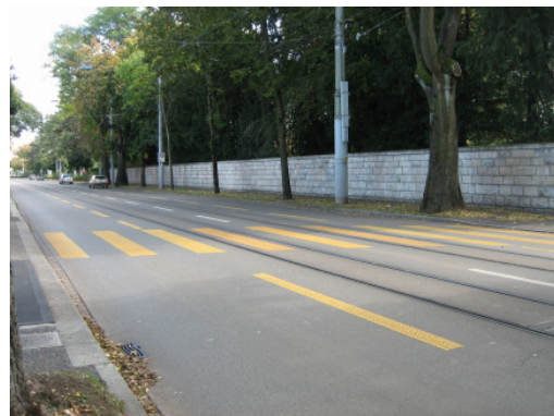
Abb. 4.39 Anordnung und Markierung von Fussgängerstreifen bei Strassenbahnen
