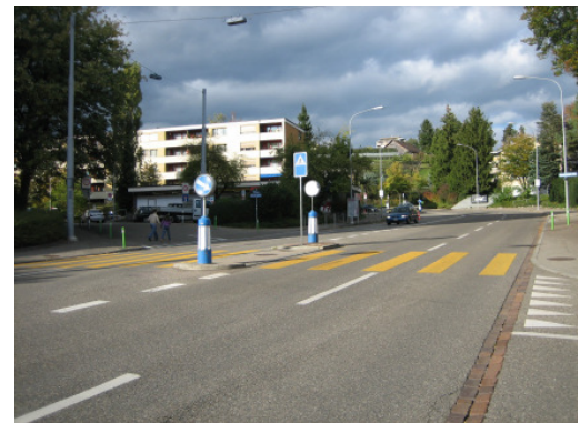
Abb. 4.44 Anordnung Fussgängerstreifen über zwei Fahrstreifen in selber Richtung
