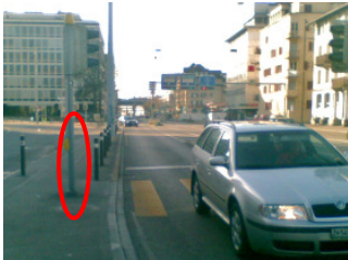
Abb. 4.37 Beispiel für Hindernis im Halteraum (Signalmast mit Signalgeber)
