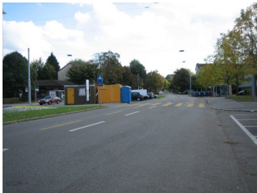
Abb. 4.44 Anordnung Fussgängerstreifen über zwei Fahrstreifen in selber Richtung
