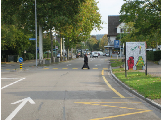
Abb. 4.36 Beispiel: fehlende Sichtweite aufgrund Werbetafel
