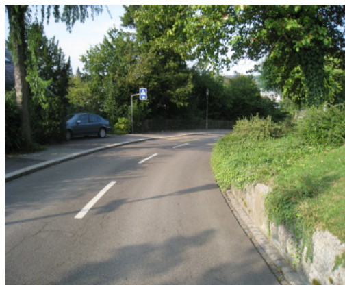
Abb. 4.34 Beispiel: fehlende Sichtweite nach links (Fussgänger versteckt hinter dem PW)
