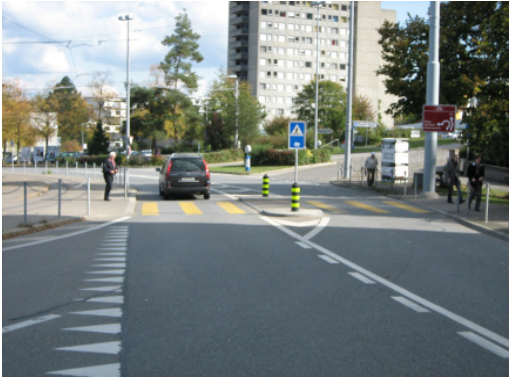
Abb. 4.45 Fussgängerstreifen mit Mittelinsel bei zwei Fahrstreifen in selber Richtung
