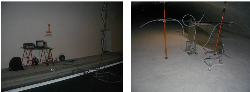
Abbildung 7: Messstelle im Fahrraum (links) und im Abluftkanal (rechts)
