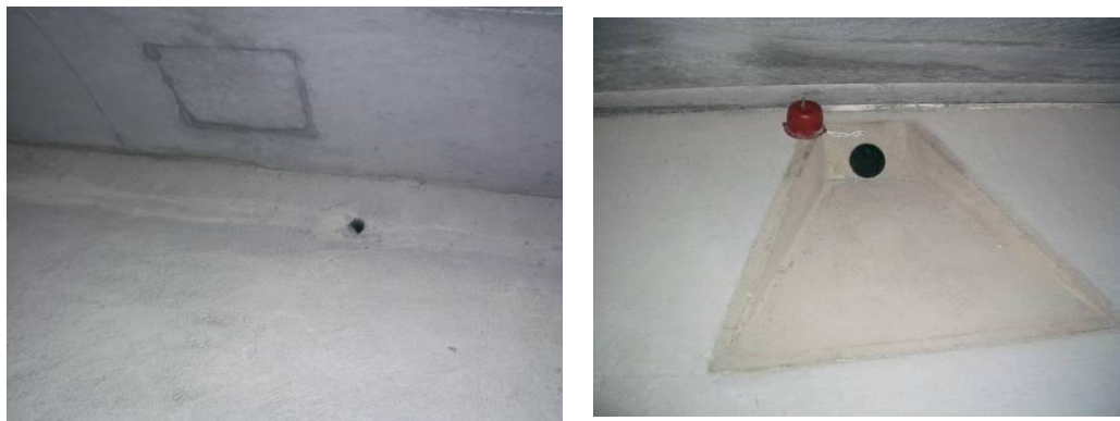
Abbildung 38: Entwässerungsöffnungen in der Zwischendecke
