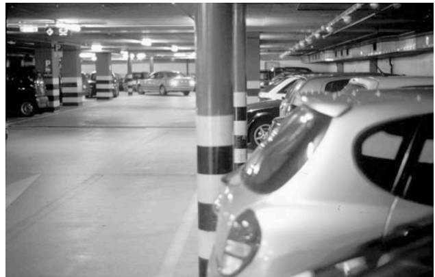
Abbildung 26: Sensoren und Positionslichter über den Parkfeldern
