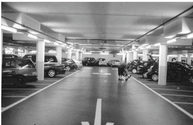
Abbildung 9: Tragwerk mit Stützen im Bereich der Parkfelder
