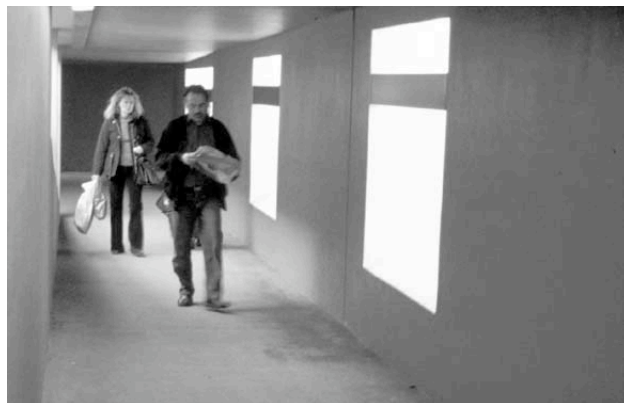
Abbildung 5: Unterhaltsfeindliche Beleuchtung mit schwer zugänglichen Leuchten in Nischen
