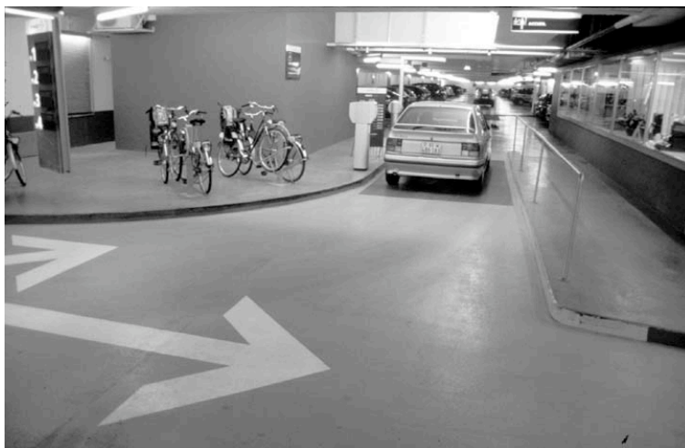
Einfahrt, Parkdeck und Betriebszentrale
