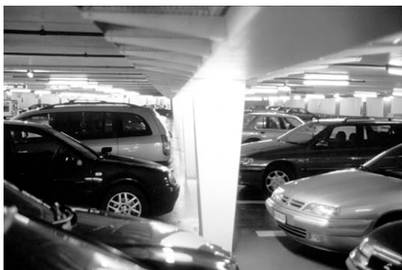
Abbildung 9: Tragwerk mit massiven Stützen ausserhalb der Parkfelder
