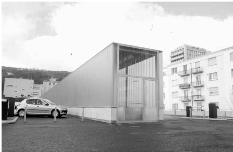
Grosses Bauwerk als Oberlicht, Eingang mit verglaster Fassade und Türe
