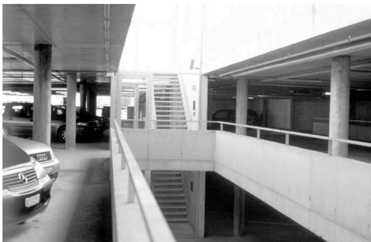
Lichtschacht in der Gebäudeachse mit den Brüstungen längs der Parkfelder als Reflektoren
