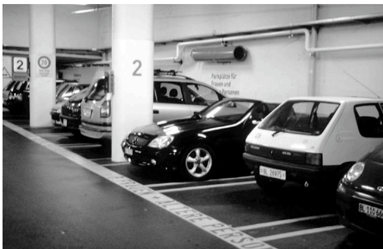
Parkdeck mit hell beleuchteten Wänden und Bauteilen
