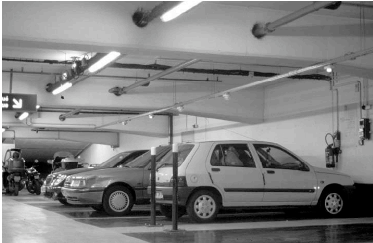
Beleuchtung mit günstiger Anordnung der Leuchten an den Fahrstreifenrändern
