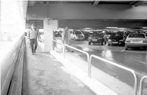
Abbildung 17: Gehweg am Parkdeckausserand
