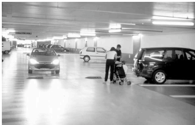
Abbildung 4: Unterhaltsfreundliche Beleuchtung mit Balkenleuchten
