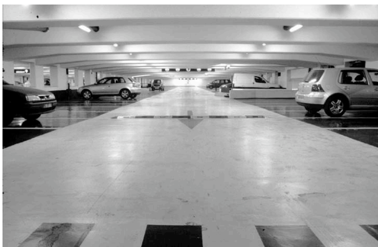
Parkdeck ohne Stützen im Bereich der Parkfelder und mit Beleuchtung der Unterzüge in weiss und blau
