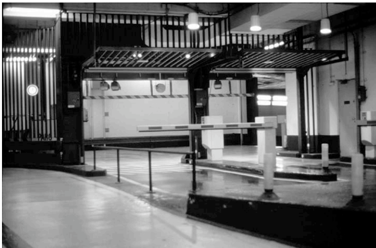
Architektonisch gestaltetes grosszügiges Einfahrtsbauwerk
