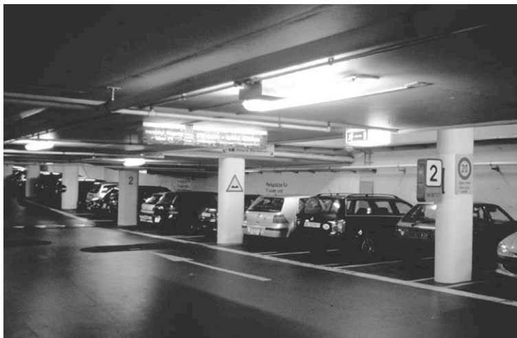
Ungünstige Mischung von Signalisierung, Orientierung und selbstleuchtenden Werbetafeln an der Decke
