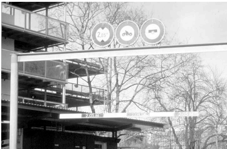
In grosser Höhe angeordnete nicht erkennbare Signalisierung an der Einfahrt
