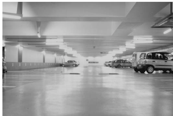
Abbildung 8: Tragwerk ohne Stützen im Bereich der Parkfelder
