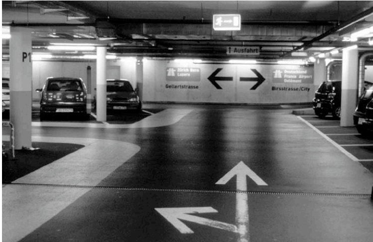
Fahrgasse mit beleuchteter Wand in Blickrichtung
