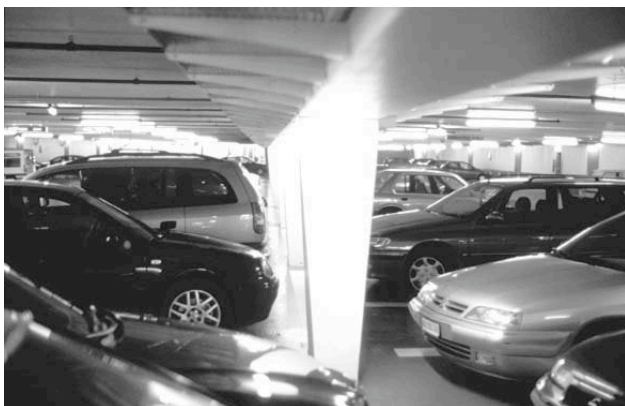
Abbildung 11: Tragwerk mit massiven Stützen ausserhalb der Parkfelder
