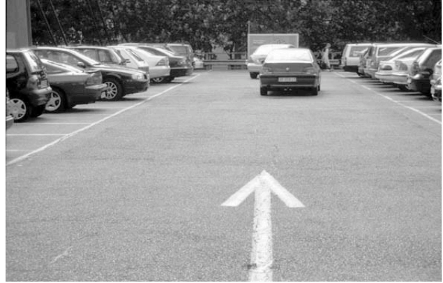
Abbildung 14: Helle Markierung auf Gussasphaltbelag
