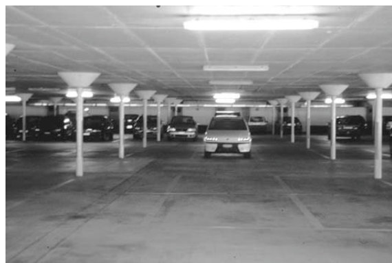
Abbildung 10: Tragwerk mit schlanken Stützen ausserhalb der Parkfelder
