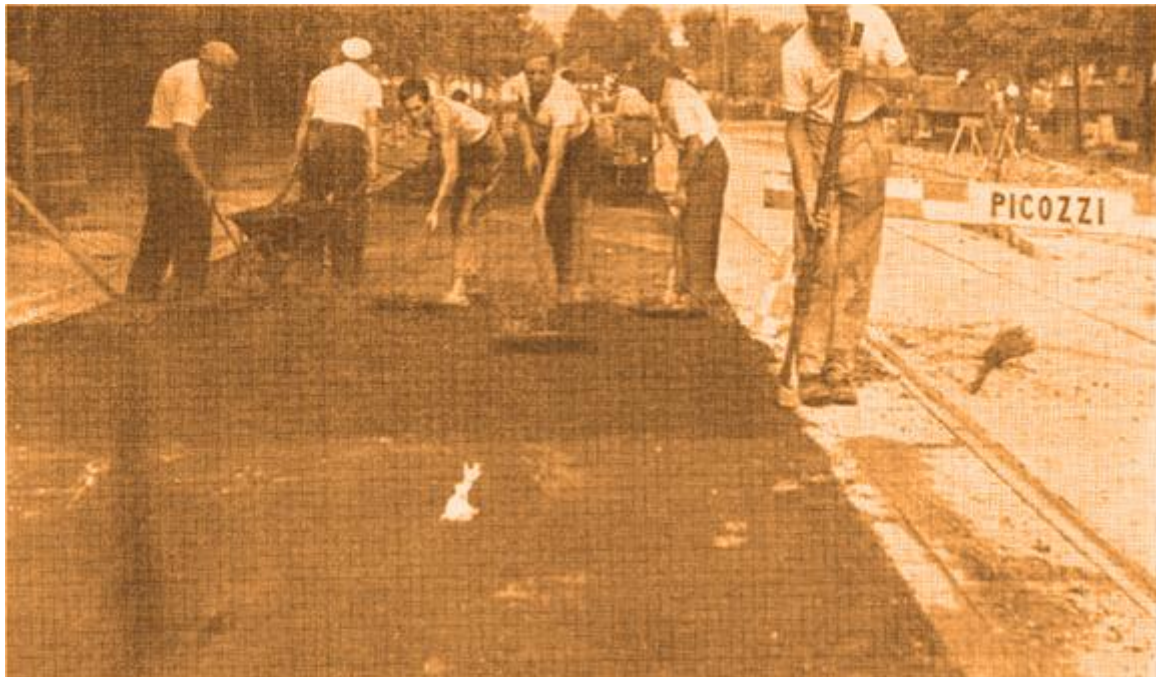
Abb. 1-1: Asphalt Beton (AB) Deckschicht (Italia, Milano ≈1950)
