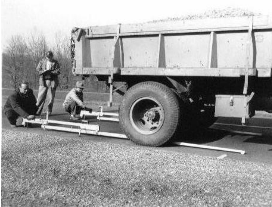
Abb. 1-8: Benkelman Beam während dem AASHO Test road, ca 1962, entwickelt bei Alvin Carlton Benkelman (1895 – 1987) (nach Alvin Benkelman, Jr.)
