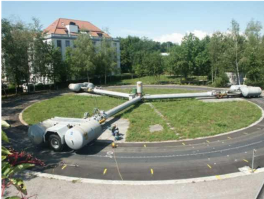
Abb. 1-2: Die Rundlaufanlage während des Unterhalts
