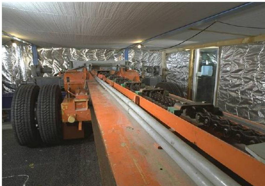
Abb. 3-2: Halle Fosse Anlage mit Klimaraum
