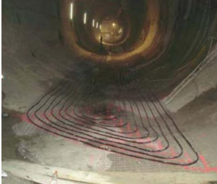
Abb. 2.23 Energiebodenplatte im Tunnelquerschnitt (U-Bahnlinie U2, Wien) [13]
