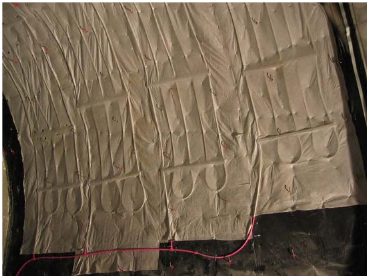
Abb. 2.5 Energievlies im Tunnelgewölbe, Lainzer Tunnel [16]
