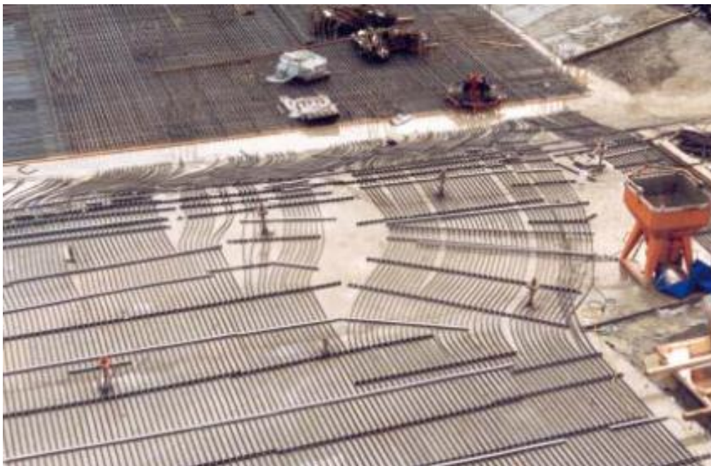
Abb. 2.22 Energiebodenplatte mit verlegten Absorberleitungen im Hochbau [13]
