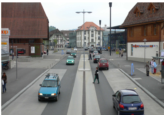
Abb. 7 Mittelzone (Mehrzweckstreifen in Fahrbahnmitte)
