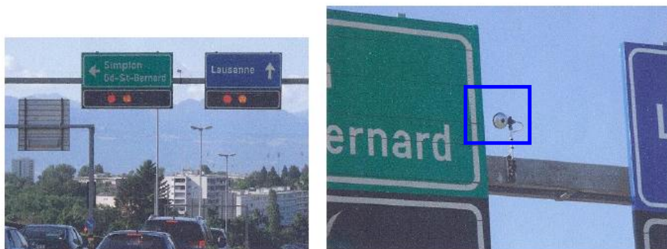
Abbildung 48: Montage des Videogerätes
