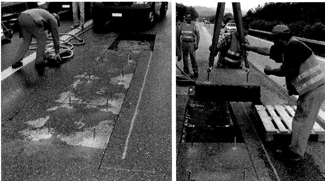
Abbildung 4.4.1: Entnahme der Belagsausschnitte
