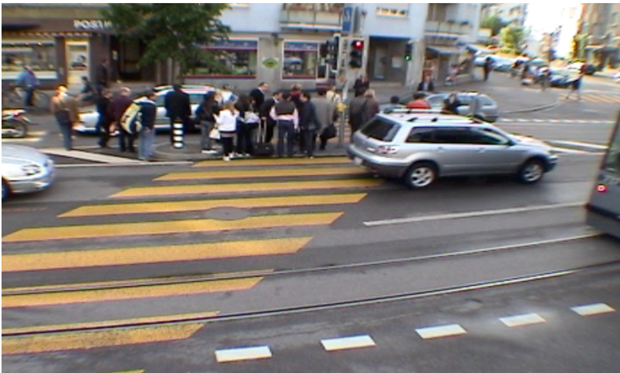
Abbildung 4.16: Zu schmale Mittelinsel und lange Wartezeiten wegen für Fussgänger zu wenig optimierter Ampelschaltung.
