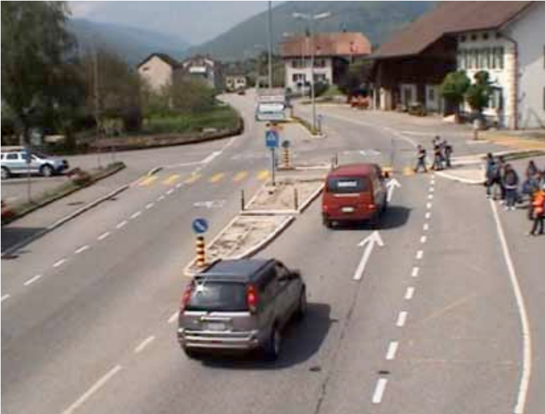
Abbildung 4.32: Kreuzung Thalstrasse – Enerholzstrasse, eine wichtige Schulwegquerung wird von den Kindern aus dem südlichen Ortsteil oft in Gruppen gequert. Die provisorisch verbreiterte Mittelinsel ist nicht optimal.
