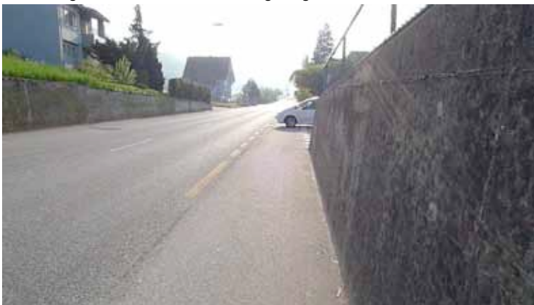
Abbildung 4.33: Thalstrasse mit ungenügenden Sichtverhältnissen.
