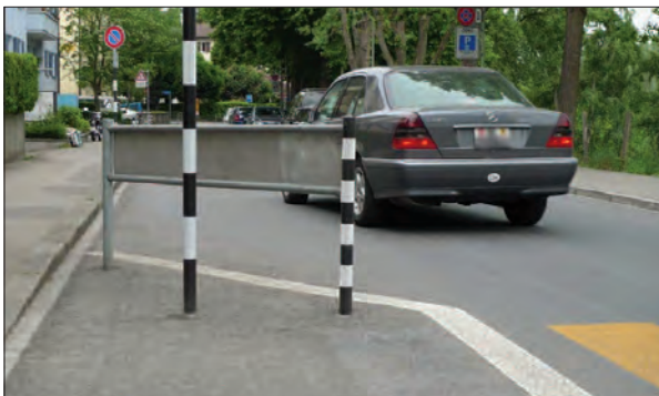
Abbildung A3.28: Die Sichtblenden sind zu breit und zu hoch angebracht, sie verdecken wartende Kindergarten-Schüler und nehmen diesen die Sicht auf herannahende Fahrzeuge.
