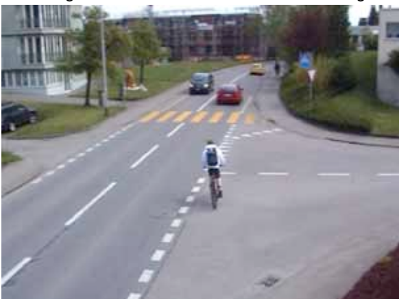
Abbildung 4.25: Überdimensionierter Einmündungstrichter ohne geschützten Raum für Fussgänger
