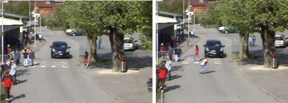
Abbildung 4.5: Ein Vertikalversatz vor einem Schulhauszugang sichert die Einhaltung von Tempo 30 und erlaubt flächiges queren bei Schulanfang. Auf das Aufmalen des Fussgängerstreifens wurde unterdessen hier verzichtet.
