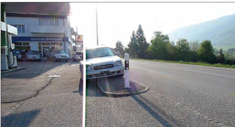
Abbildung A3.48: Die ausgestellten Autos bei der Garage verdecken die Sicht auf die Thalstrasse.
