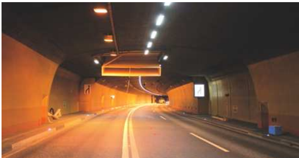
Abbildung 4.10 Saccardo-Düse im Fahrraum-Querschnitt
