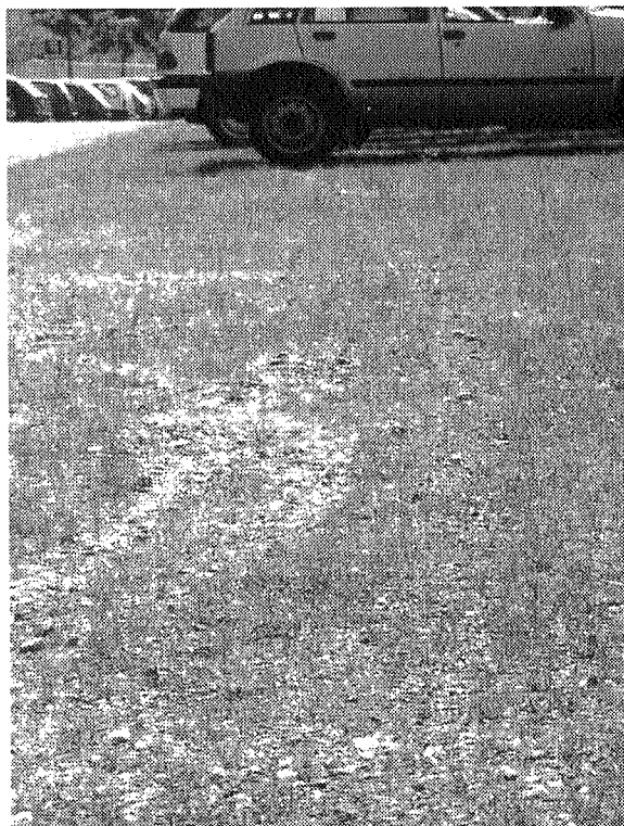
Abbildung 15 und 16 Parkplätze für Personenwagen mit Kiesrasen und mit Rasengitterelementen
