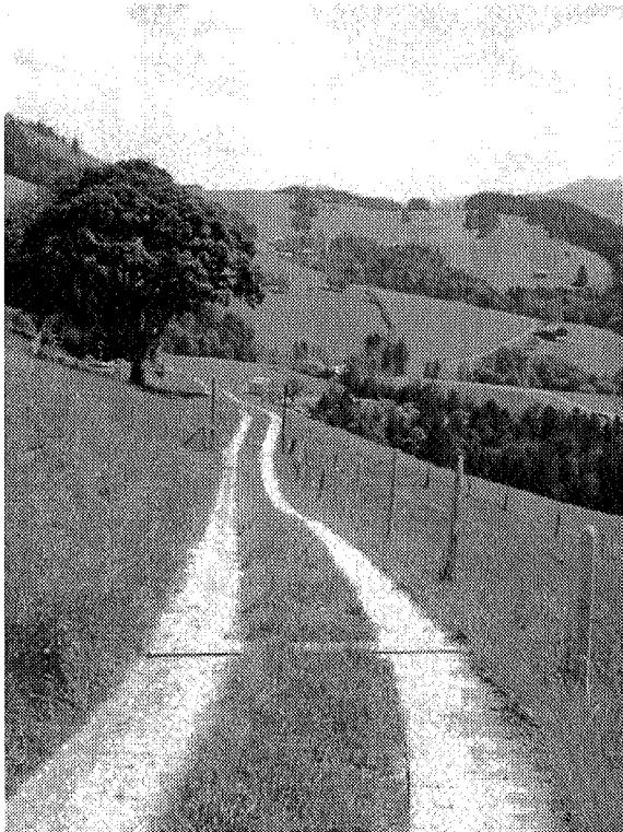
Abbildung 5 und 6 Güterstrasse (Spurstrasse) und Wanderweg mit Rasengitterelementen
