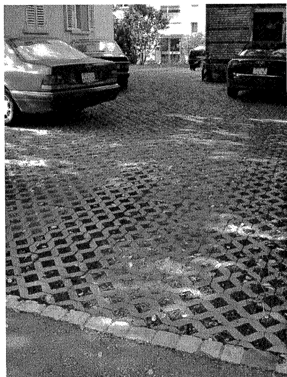
Abbildung 15 und 16 Parkplätze für Personenwagen mit Kiesrasen und mit Rasengitterelementen
