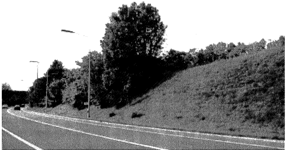
Bild 3: Bepflanzung entlang Autostrasse
