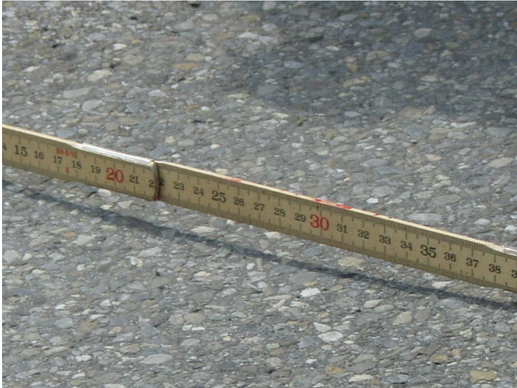
Abbildung 17: Spurrinnen in der Normalspur
