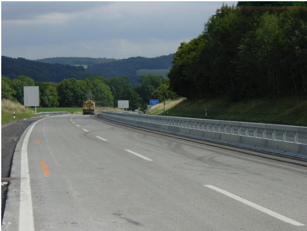
Abbildung 16 Objekt FR1; Blick Richtung Bern
