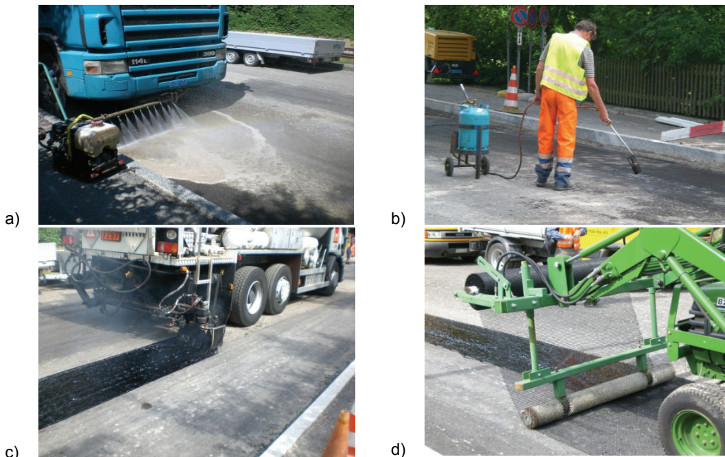
Abb. 2.16 a) Reinigung der Strasse; b) Trocknung der Strasse; c) Spritzung Bitumenmembran; d) Verlegung der Asphalteinlage
