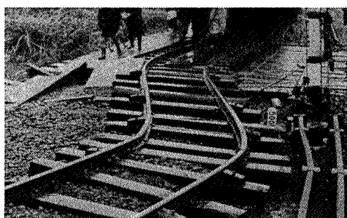
Fig.2.2. Ondulations d'une voie de chemin de fer.
